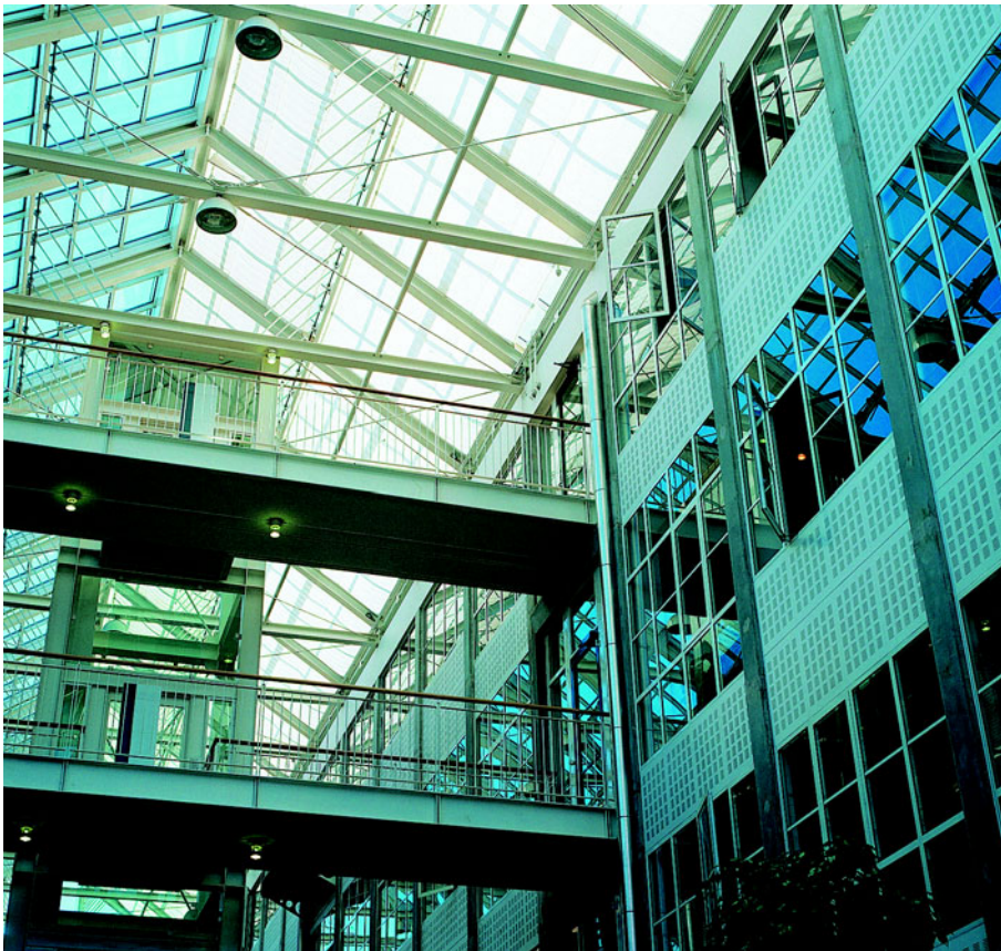
Atriets tagkonstruktion og den nye bygnings facade mod atriet.
