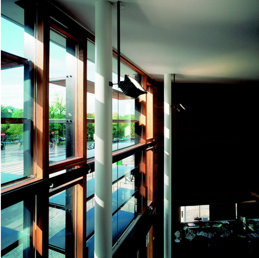
Foyeren med udvendige, faste lameller mod syd.
