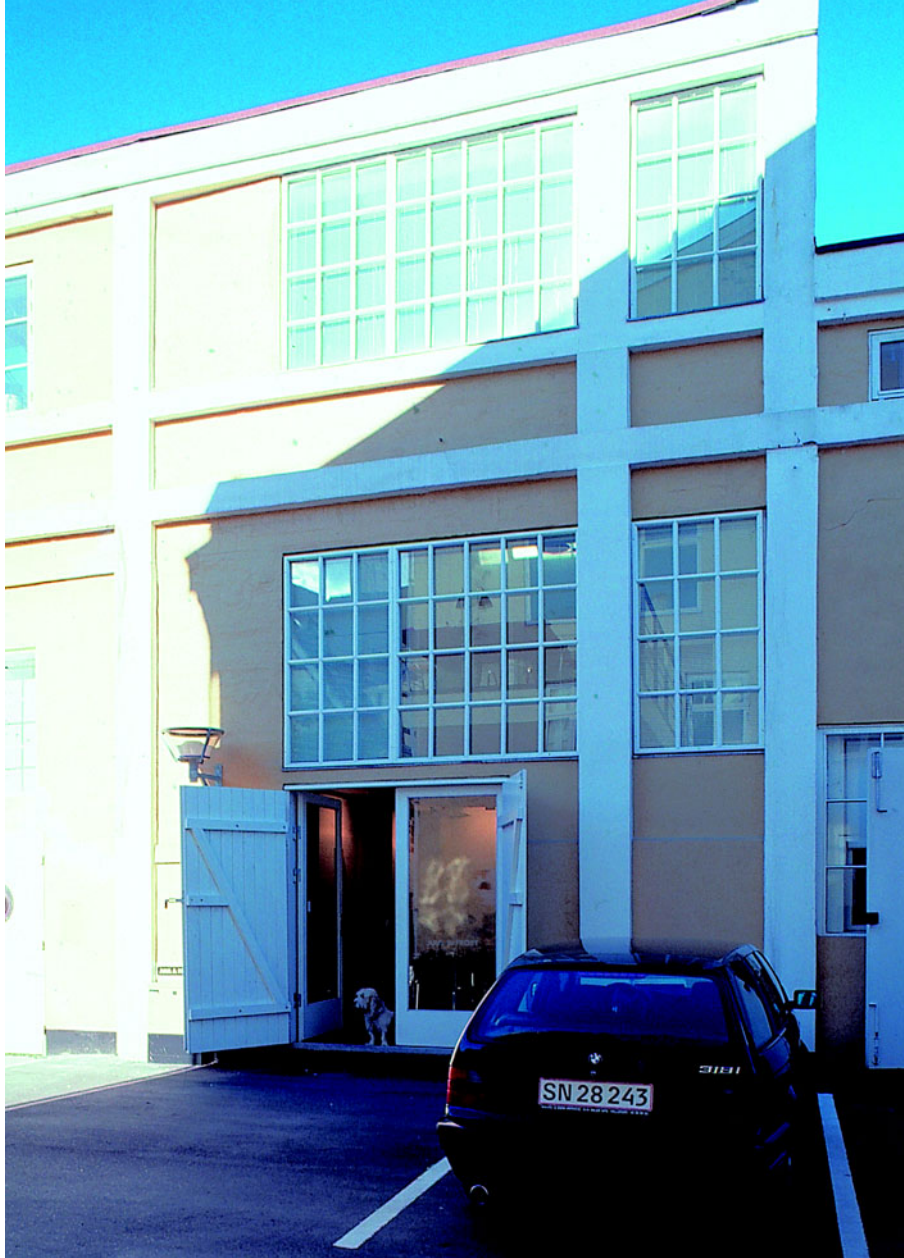
Indgangspartiet og facaden med vinduer.
