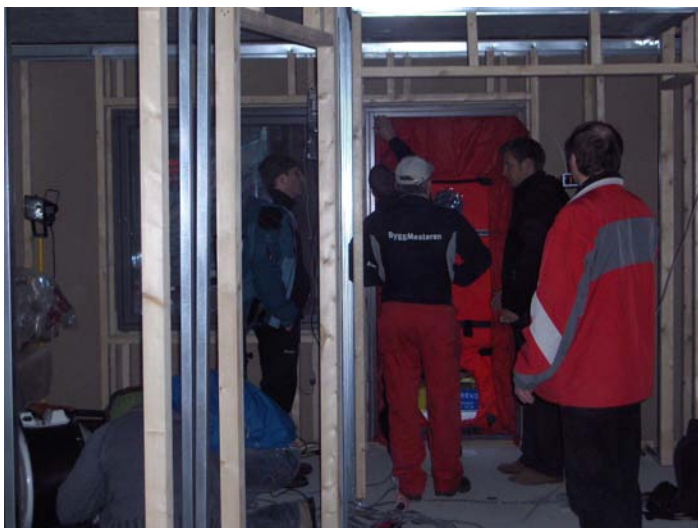
Figur 7: Trykktesting av leiligheter med kun utvendig vindtetting.
