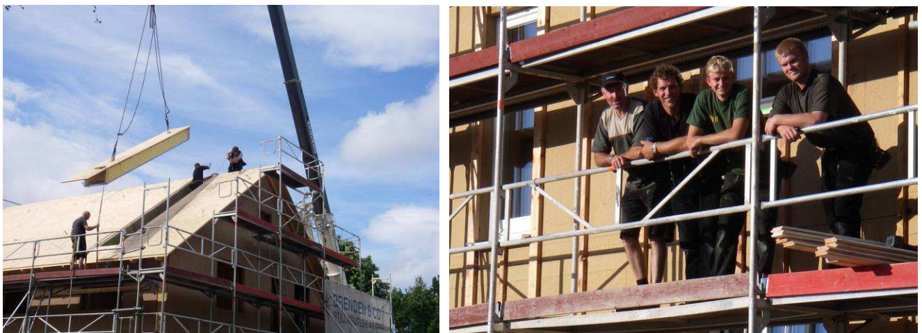
Figur 1 og 2 Siste takelement heises på plass (t.v.). Arbeidslaget fra Tyskland er fornøyd. Foto: Harald Ringstad
