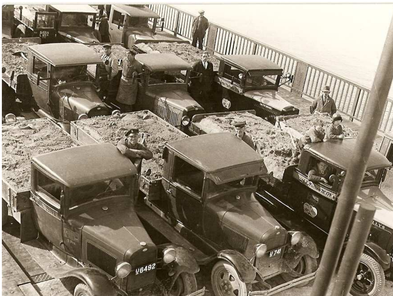
Belastningsprøven på Limfjordsbroens to broklapper blev foretaget den 22. marts 1933. Indforskrivet til testen hos byens vognmænd var 48 Ford Model A lastbiler læsset med grus. Symbolikken er med på læsset, er det nødvendigt at nævne, at broen holdt fint til denne belastning af fremskridtet.
