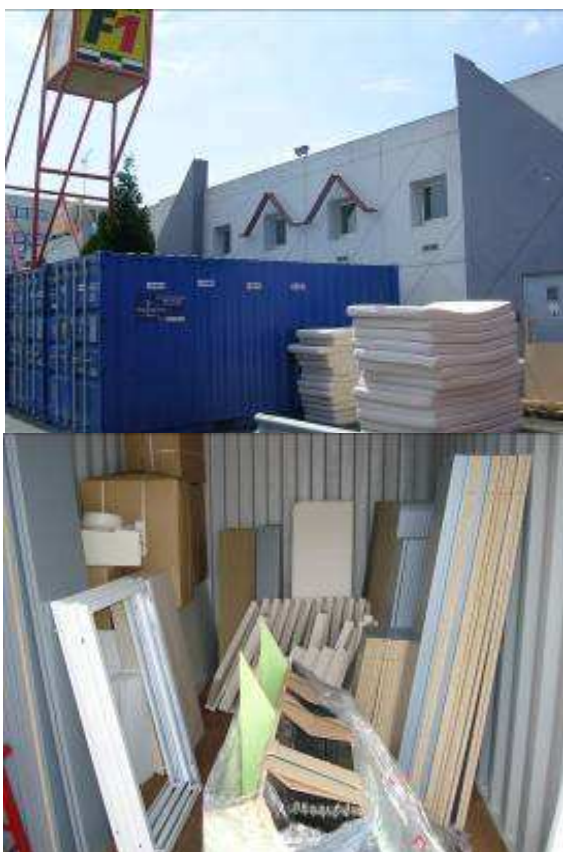
Figur 10: Container lagrer udstyr og materialer. (Foto: Frédéric Bougrain).
