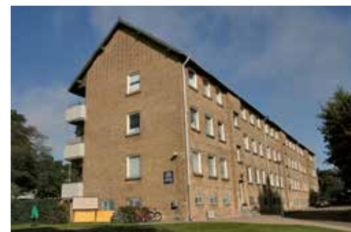
Gavl/facade (kilde: Københavns Museum).
