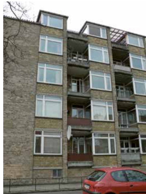
Bispeparken før renoveringen.
