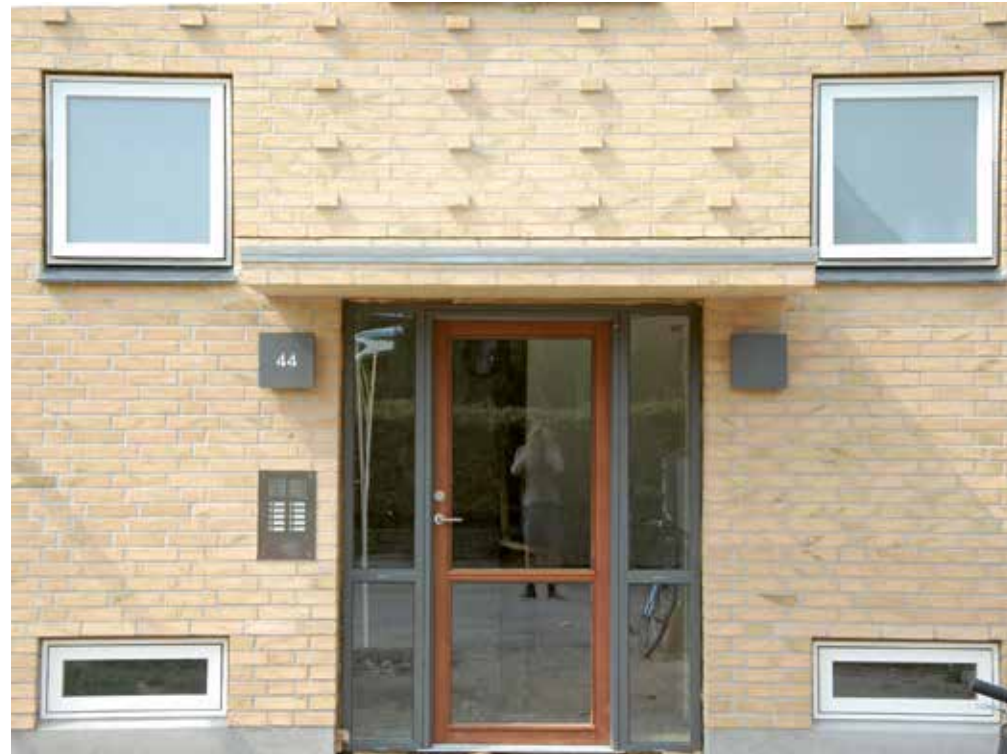
Indgangspartiet er fornyet, og vinduerne er udskiftet med nye udadgående vinduer af træ og aluminium.
