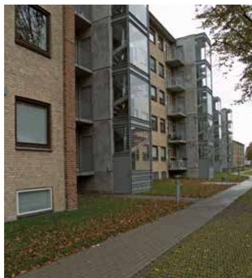
Eksempel på placering af et elevator-/trappetårn uden på facaden, der understreger de vertikale træk i facaden og samtidig muliggør adgang til alle lejligheder i opgangen for både beboere og besøgende, uafhængigt af funktionsevne. Eksemplet er fra Vanggården i Aalborg, opført 1941-1943
