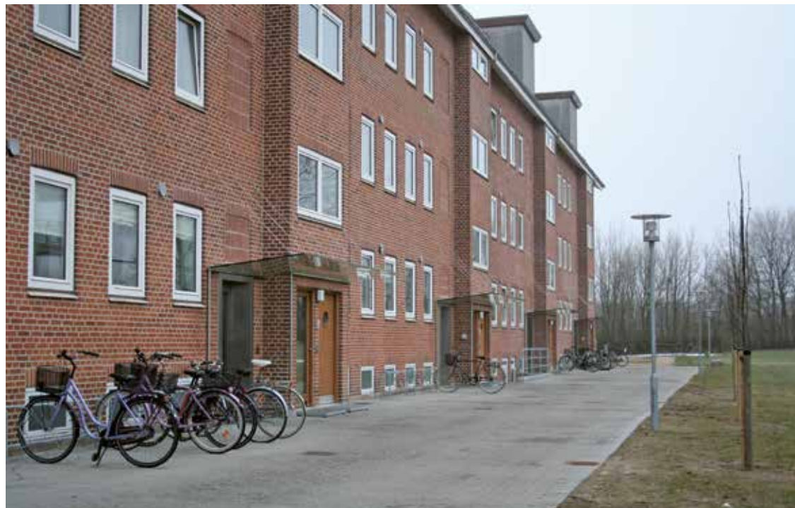
For at forbedre tilgængeligheden er der etableret elevatorer ved indgangspartierne til venstre for de eksisterende indgangsdøre i alle opgangene.
