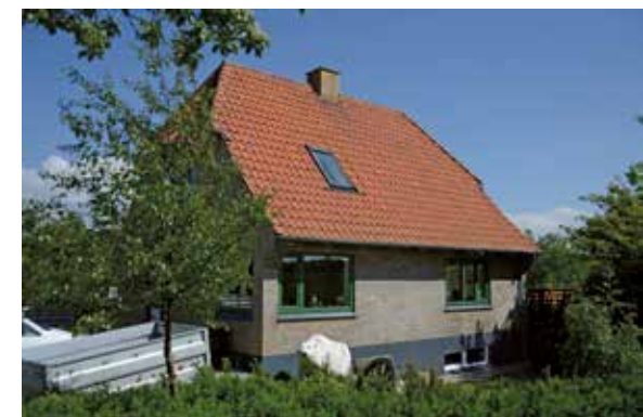
Et før og efter-billede af et parcelhus fra 1956, hvor nyt koncept til energiforbedring af murede facader er anvendt. Den meget nedslidte formur er revet ned og erstattet af en ny og slankere, der giver plads i hulmuren til mere og bedre isolering. Konceptet er ved at blive videreudviklet til brug i etageejendomme.
