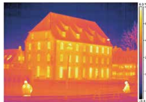
Figur 1. Termografi af bygning med angivelse af kuldebroer
