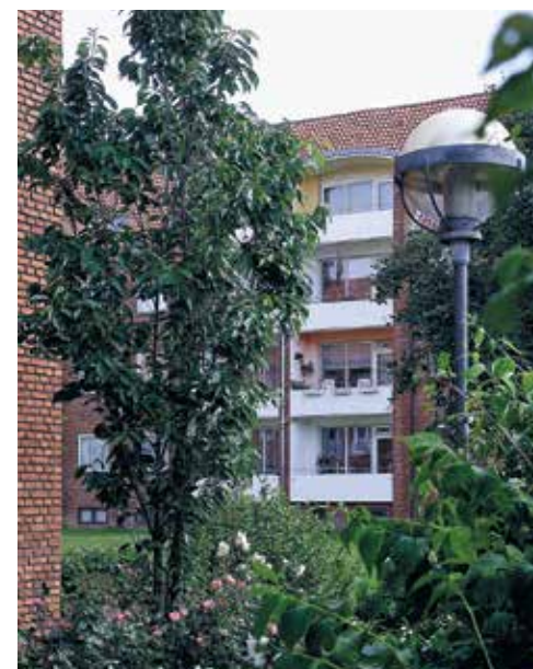
Altanen giver kvalitet til den enkelte bolig og er et vigtigt element i detaljeringen af arkitekturen. Bag Rådhuset i Hvidovre fra 1954, Lejerbo.
