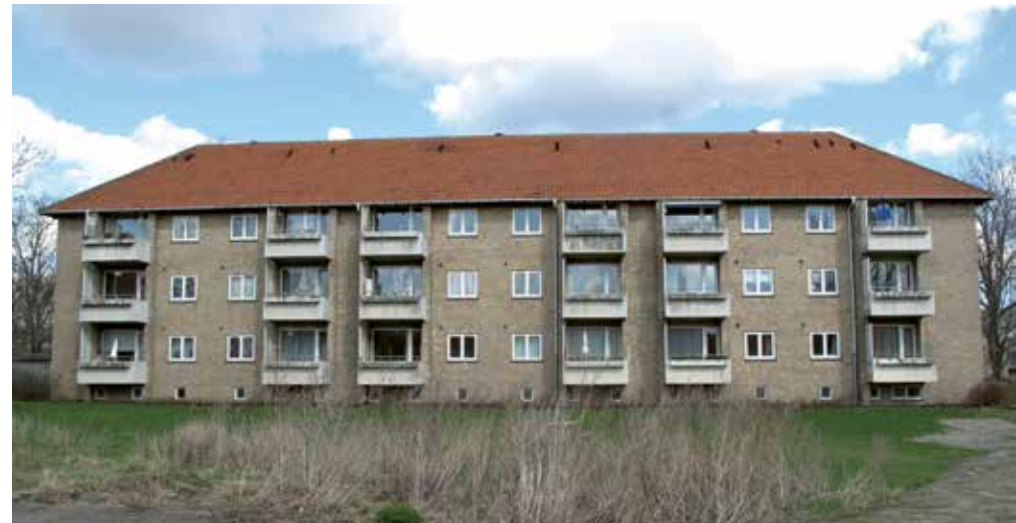
Fortunbyen før renovering
