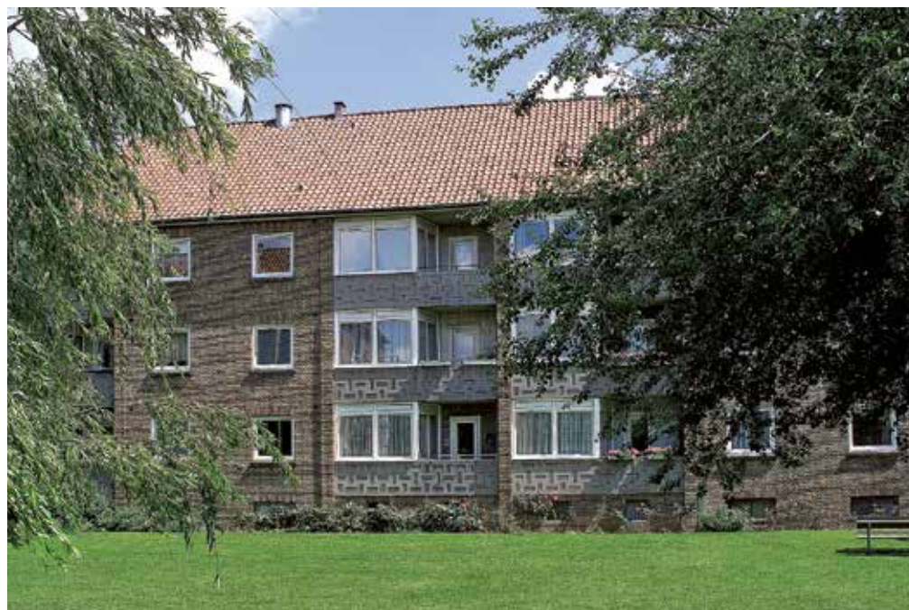
Brystninger ved altaner understreger bygningens vertikale liner. De er udført i beton - her med en mild ornamentering. Spurvegården, Hvidovre, fra 1952, Lejerbo.
