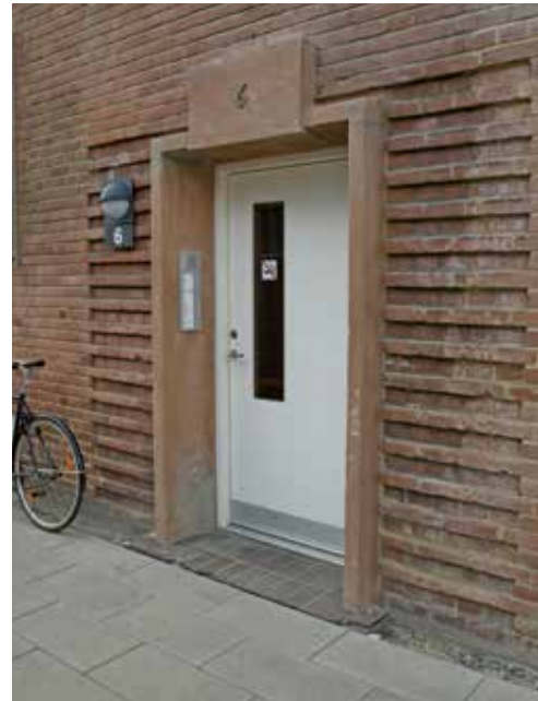
Et eksempel på, at arealet foran hovedindgangen er hævet, og niveauforskellen er dermed udlignet, og indgangen blevet niveaufri. Derudover er kontrasten mellem murværk og dør en god hjælp til beboere med synsnedsettelse. Eksemplet er fra Ringgården i Aarhus.
