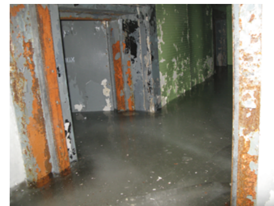
Der er fri adgang til det indre under vagttårnet på D Launch, som dog er delvist fyldt af is. Tilsvarende rum under A Launch i Dundas er aftalt brugt til deponering af affald fra oprydningen af de lossepladser på Dundas, amerikanerne har efterladt.10 (Foto: Ulrik P. Gad).
