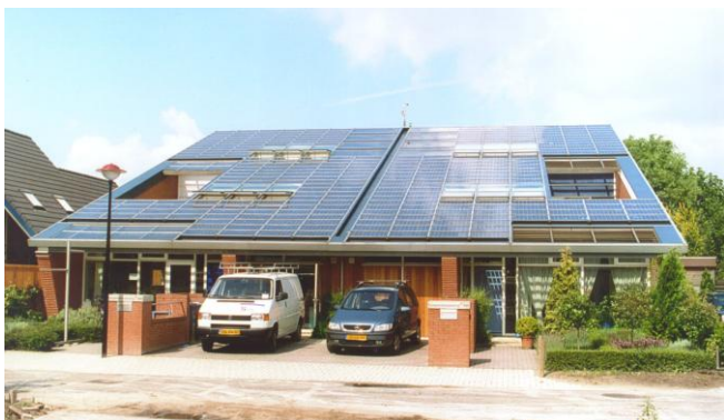
Figur 8. Eksempel på et hollandsk nulenergihus med tag bestående af solceller samt solfangere.
