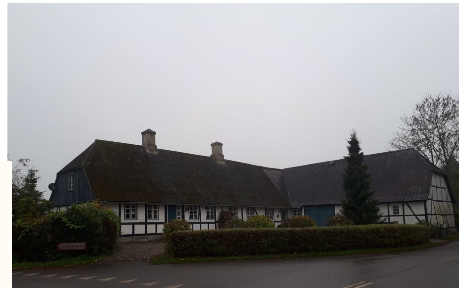
Stuehus i Utterslev (på Vestlolland) under istandsættelse, solgt som flex-bolig til familie fra Hvidovre
