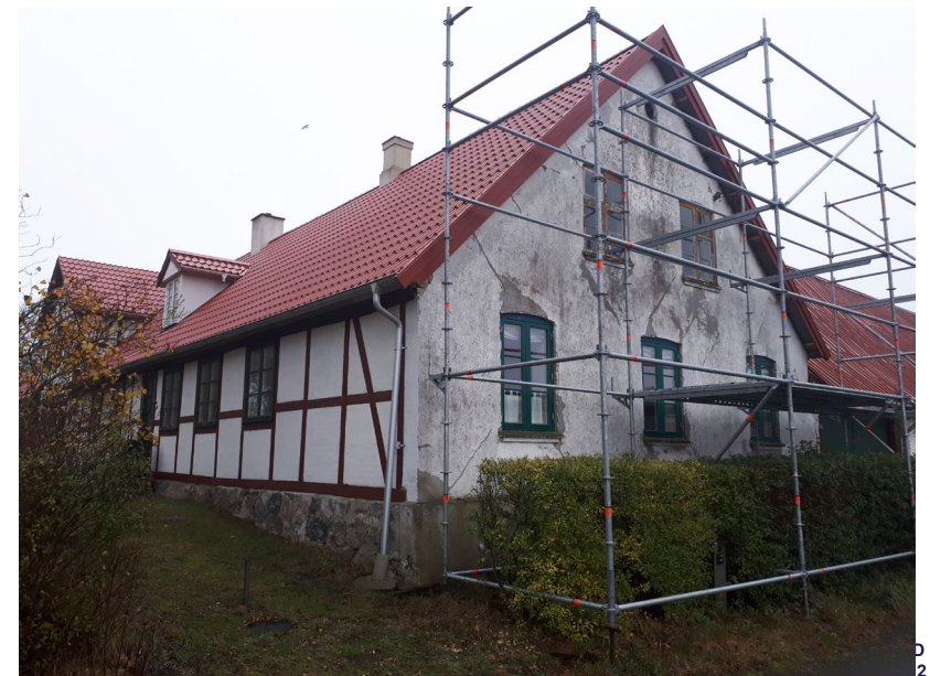
Stuehus i Utterslev under renovering
