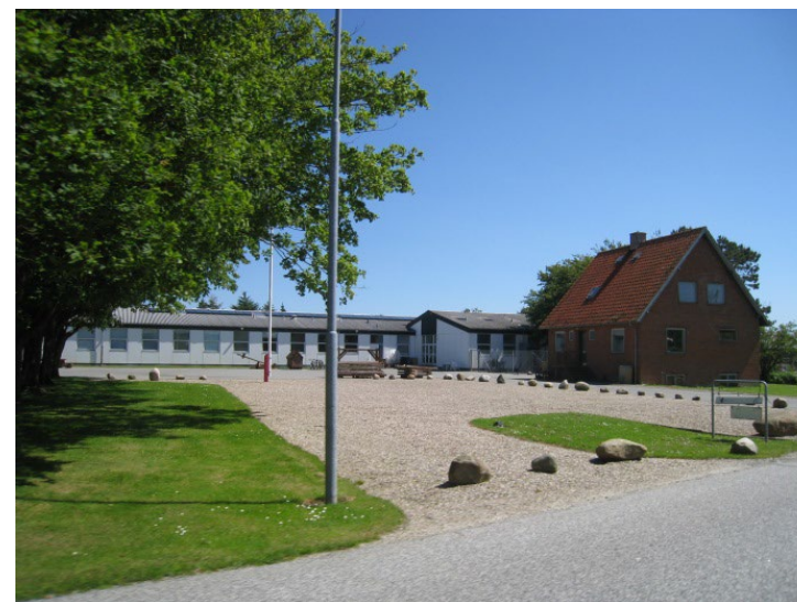
Grunde, der er ryddet foran skole i Morsø Kommune. Bygningen til højre (og en anden bygning til venstre på den anden side af skolen) forventes også nedrevet på sigt, når ejer flytter.
