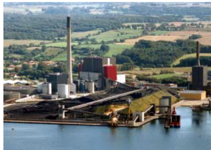
Enstedværket (Dong Energy, 2007a)
