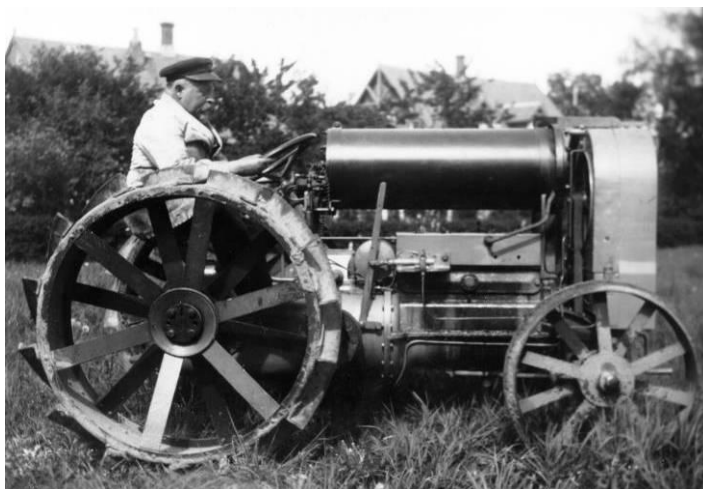
Ellehammers dampmotor i en Fordson traktor med opfinderen selv ved rattet. Foto: Danmarks Tekniske Museum
