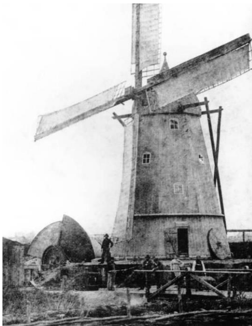
Ellehammers far, Mads Hansen, opfandt en vandløfter, der tømte inddæmningen ved Vålse Vig for vand. Vandløfteren ses til venstre for møllen. Foto: Danmarks Tekniske Museum
