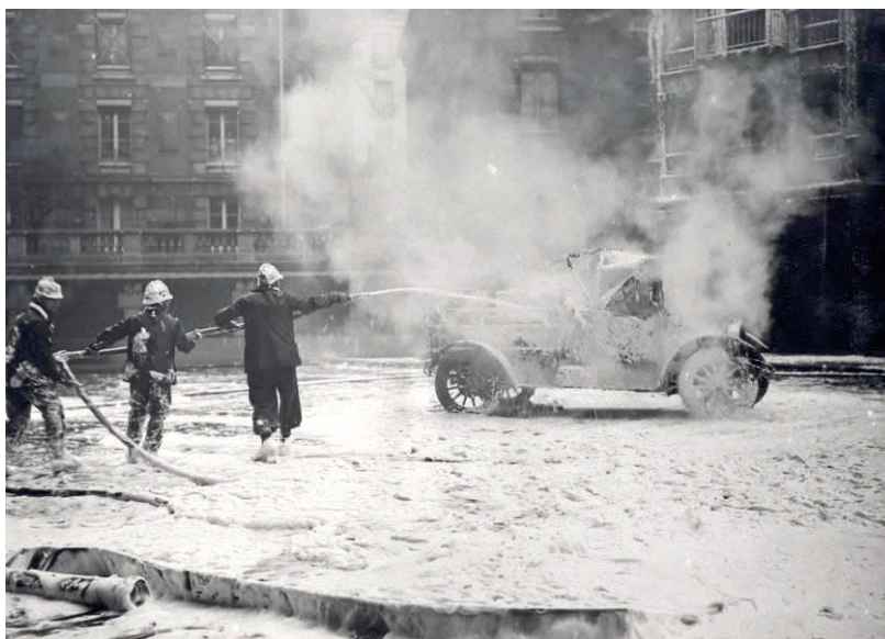
Ellehammers skumslukningssystem demonstreres i Paris i 1937. Foto: Danmarks Tekniske Museum
