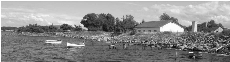
Dæmningen over Vålse Vig og den nuværende pumpestation holder 1600 ha land inddæmnet. Foto: Danmarks Tekniske Museum
