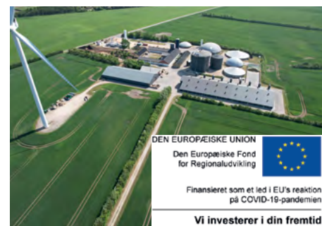
Figur 20: Billede af GrønGas' anlæg ved Hjørring.
