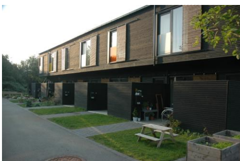
Figur: Øverst: Bebyggelsen set fra den fælles grønning. Nederst: Den ene boliggade, med de små skure, der skaber struktur og rytme, og som laver en klar markering af boligernes adgangsforhold
