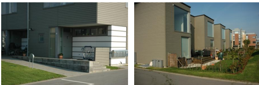
Figur: Til venstre ses udsnit af indgangsfacade med et overdækkede areal omkring indgangene. Til højre ses havefacaden med de store vinduespartier, der markerer boligernes dobbelthøje rum.
