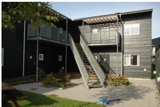
Figur: Adgangsforholdene til boligerne er samlet omkring et lille gårdrum – her Dalles Have.
