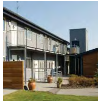
| Hurup. Nye ældrevenlige boliger med elevatoradgang.
