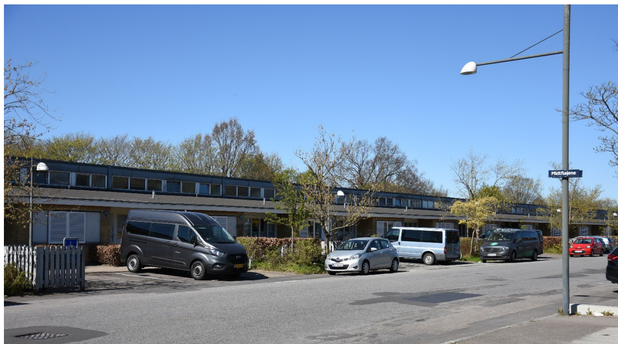
42 rækkehuse langs Langhusvej forventes nedrevet. Nedrivningsplanerne har ført til protester fra flere af rækkehusenes beboere.
