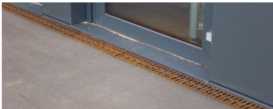
Figur 26. Linjedræn anvendt som fugtsikring foran indgangsparti. Korrekt udført, men den manglende fri sokkelhøjde giver dårlig sikring mod indtrængning af vand, hvis kloak afløbet ikke kan bortlede vandet under skybrud. Viborg.
