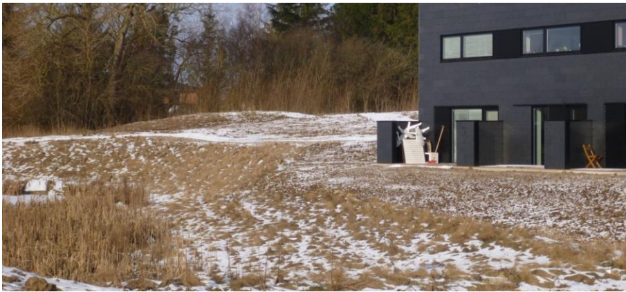
Figur 13. Terrasser i træ hævet over naturligt terræn. Der er kraftigt fald på terræn fra bygning hen mod overløbsreservoir. Mårslet.
