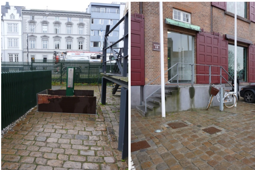
Figur 31. Løfteplatforme nedbygget i terræen, udendørs. Vand, sne og frost kan nedsætte driftssikkerheden væsentligt, og siden 2008 har bygningsreglementet ikke tilladt anvendelse af trappelifte og løfteplatforme til at sikre niveaufri adgang udefra og i fælles adgangsveje. Aarhus.
