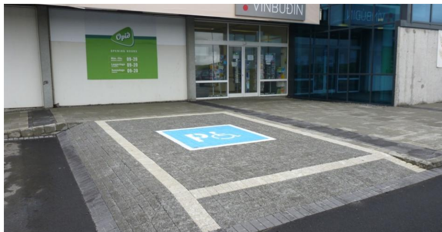
Figur 10. Hævet indgangsparti inklusive parkeringsplads. Gangarealer og parkering er hævet op over det omliggende område. Hella, Island.
