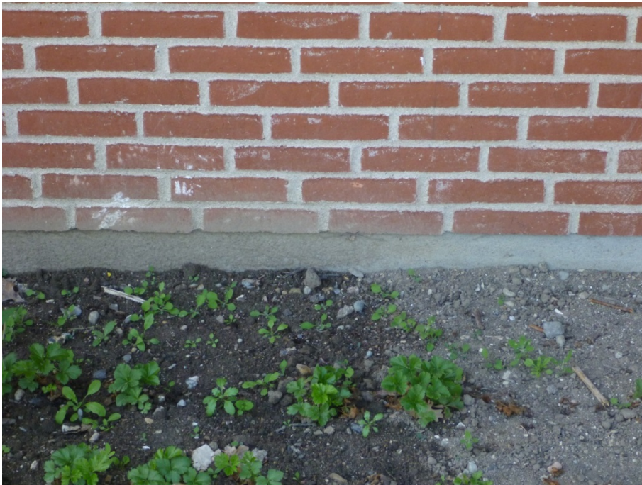
Figur 76. I venstre side: transport af jordpartikler op til ca. 200 mm højde. I højre side, hvor der er overdækket indgangsparti, er der ingen særlig "transporteffekt" af opsprøjt. Facaden er 3-etagers, beskyttet af tagrende og nordøstvendt.
