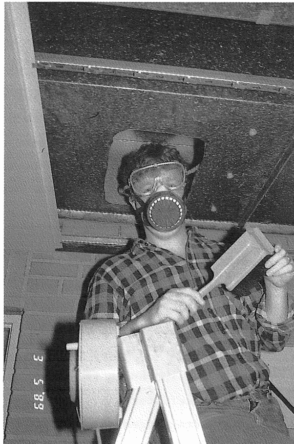
Figur 2. Adgang til kanalerne skete gennem udfrasede åbninger.
