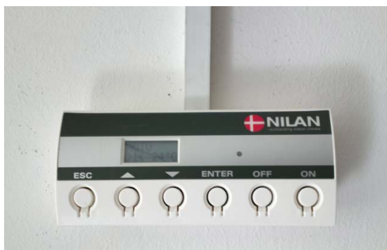
Foto 13 Typisk styreenhed for ventilations/varmeanlæg med varmegenindvinding. Toftegårdsvænget, Asminderød
