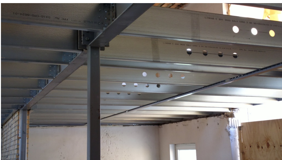
Foto 16 Nyt etagedæk af stål (Baldersbo, Ballerup)
