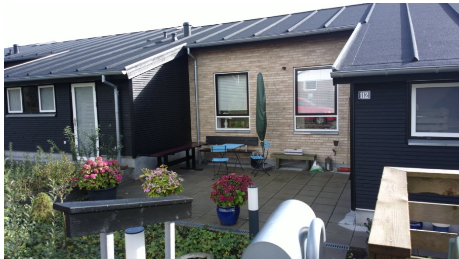
Foto 28 Nyrenoveret hus, forhave, Møllevangen
