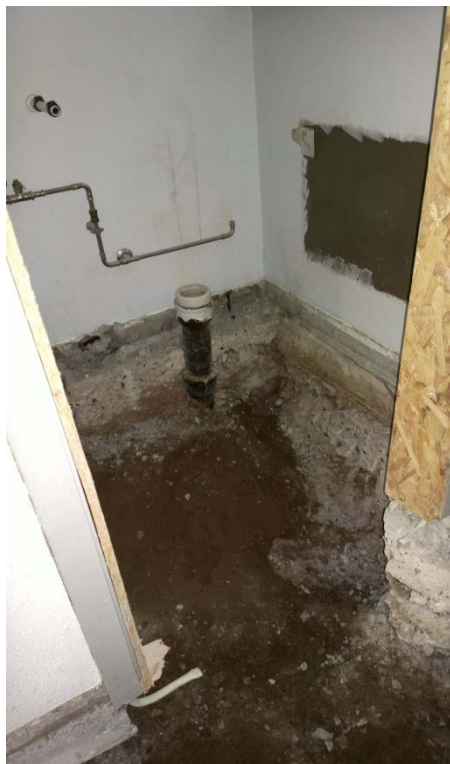
Foto 24 Udgravning for nyt terrændækning. Græsvangen sep. 2015
