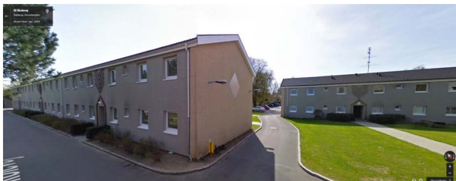
Foto 51 Baldersbo før renovering. Kilde : Google maps
