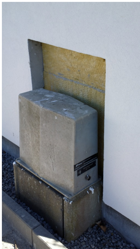
Foto 55 Der er udført udvendig facadeisolering, dog har det været økonomisk urealistisk at flytte elinstallasjon for at få plads til isoleringen. Toftegaardsvænget, Asminderød
