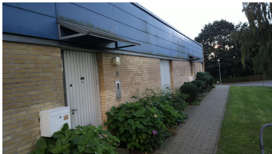
Foto 31 Hovedindgangspartier, der er ikke planlagt efterisolering af disse facader hvorimod de lette facader imod havesiden efterisoleres. Stenhøjgaardsvvej
