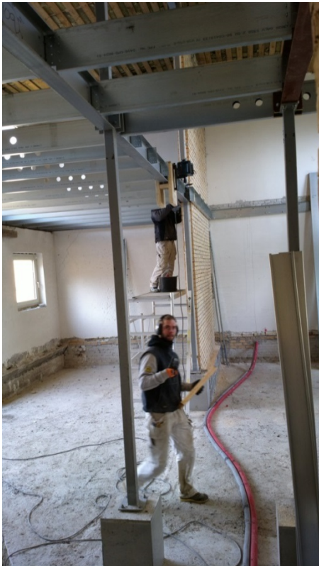
Foto 52 Etablering af ny etageadskillelse i stål samt opbygning af nye bærende indervægge. (Baldersbo, Ballerup)
