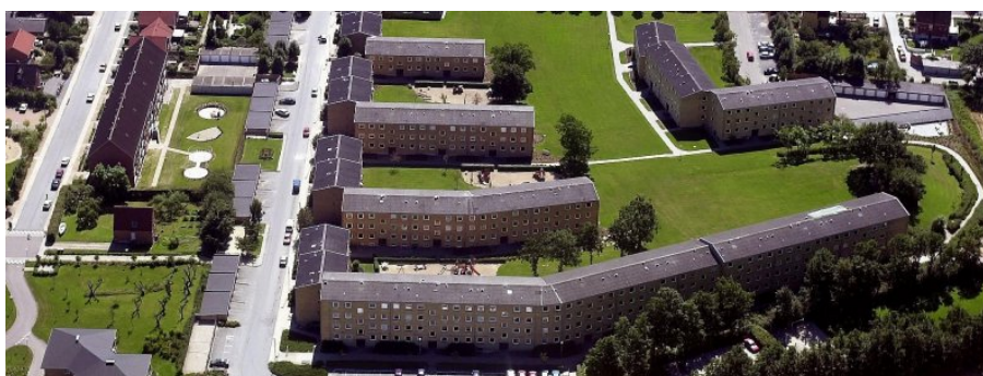
Foto 21 Bjellerupparken Kilde: Google maps
