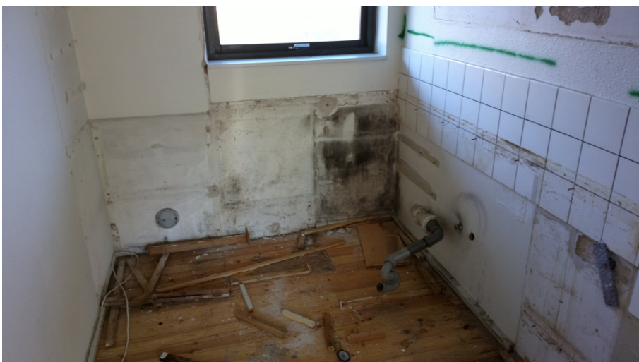
Foto 39 Alle installationer fornyes, badeværelser opbygges på ny. Munkebjergparken
