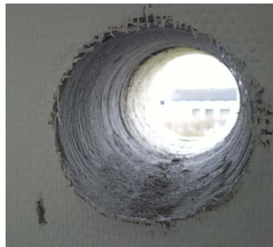
Foto 46 Der er etableret udvendig isolering af facaden, her med udboring til emhætteafkast igennem den nye samlede vægtykkelse. Kapellanvej, Holbæk
