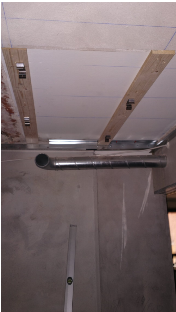
Foto 18 Ny ventilation (indblæsning) udmunder i stue ) Jyllandsgade
