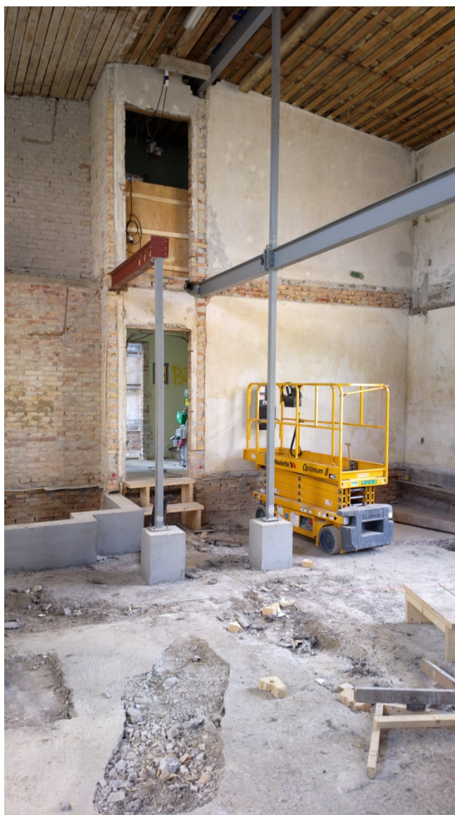
Foto 14 Meget omfattende renovering hvor alene bygningskallen (tag og ydervægge) står tilbage. Der opbygges ny etageadskillelse med stålkonstruktioner, som bæres af nye fundamenter (Baldersbo, Ballerup)
