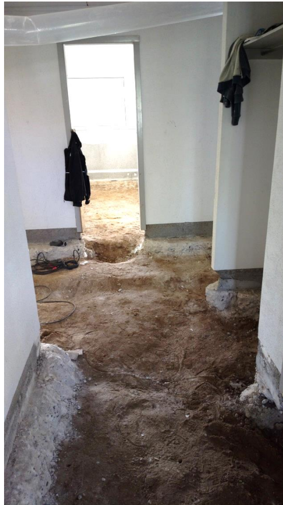
Foto 2 Oprindelige gulve fjernes og der udgraves mhp nyt kapillarbrydende lag og isolering. Græsvangen, Aarhus
