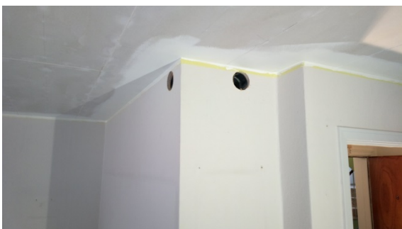
Foto 19 Ventilationsrør fremføres i kommende nedhængt loft (Jyllandsgade)
