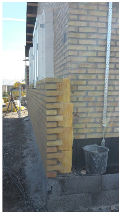
Foto 41 Etablering af ny muret facade med isolering. Peter Hansensvej, Fåborg. Foto: Turid Øien
