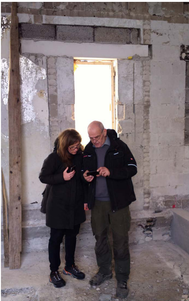
Foto 1 Udbytterig rundgang på byggepladsen med ejendomsfunktionær (vicevært) . Gl. Skolevej Ballerup
