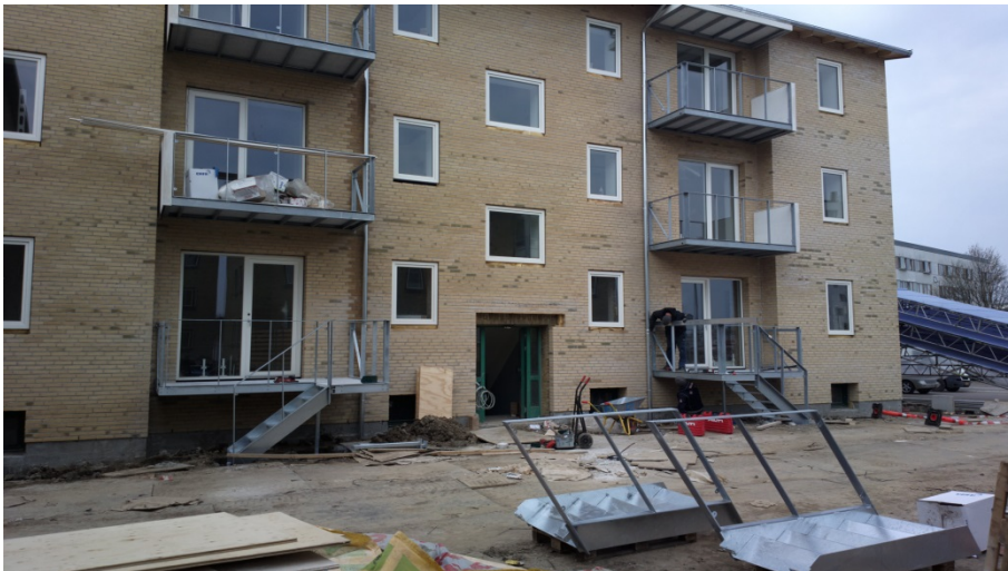
Foto 49 De renoverede facader med altaner. Ulvefodsvej, København
