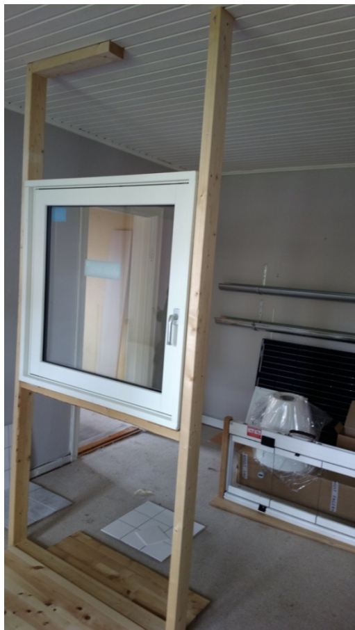
Foto 4 Mock-up af vinduesløsning i prøvelejlighed hvor også køkkenelementer kunne seses. Ulvefodsvej, København
