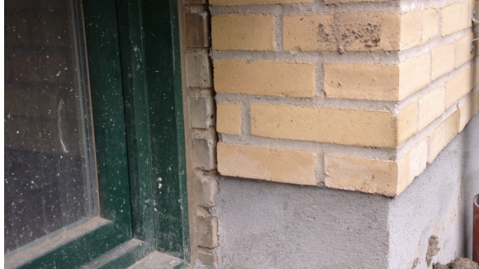
Foto 48 Den nye isolerede skalmur uden på den gamle gulstensfacade. Ulvefodsvej, København
