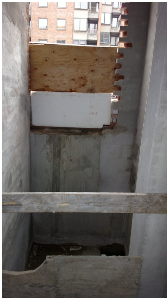
Foto 6 Landsbyggefonden stiller ofte krav om at renoveringsprojektet skal indeholde etablering af boliger med høj tilgængelighed. Her ses etablering af elevatorskakt i et byggeri, som er opført uden elevator (Jyllandsgade, Randers)
