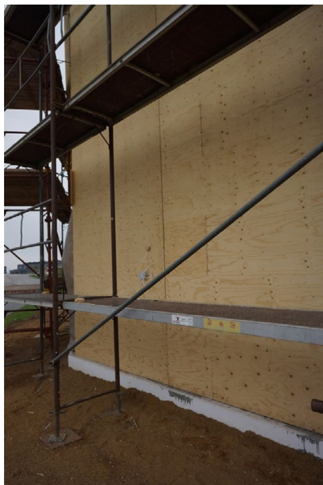
Figur 111. Foto af væg udefra – med føler placering i yderste isoleringslag.
