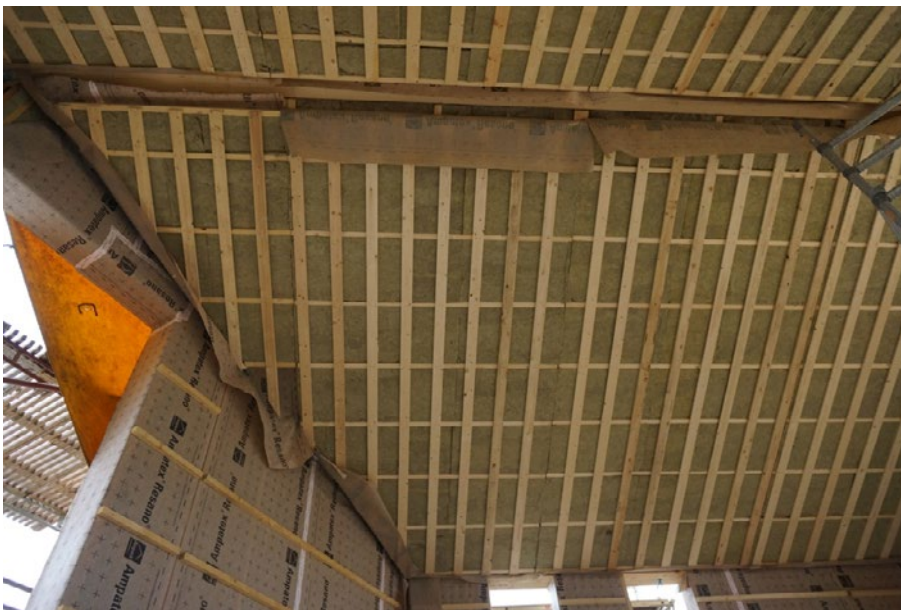
Figur 109. Foto af tag og vægge under bygning.
