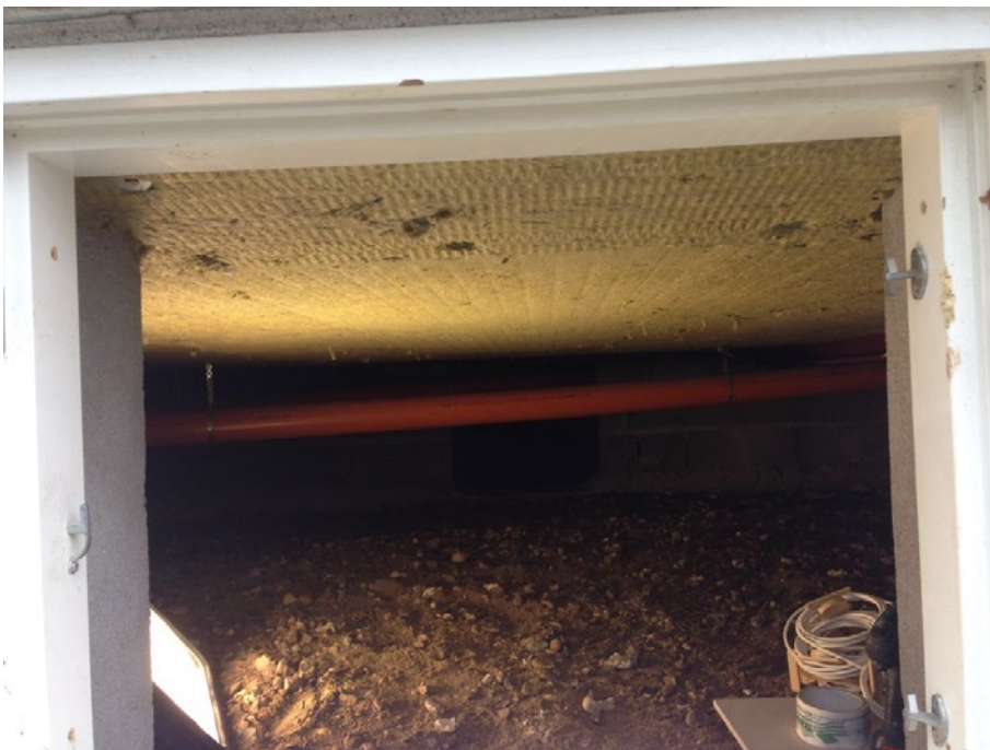
Figur 117. Krybekælder med isoleringsbatts på undersiden.
