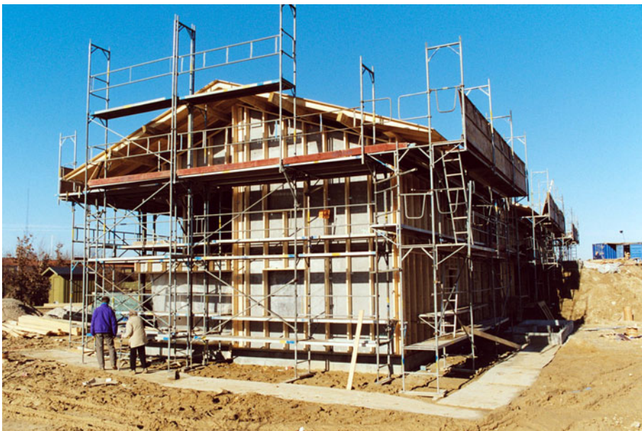
Figur 4. Det første længehus forsynes med den tagkrydsfiner, som udgør underlaget for tagdækningen af sort tagpap. Endvidere monteres træstolper på den, bærende bagvæg af letklinkerbeton.
