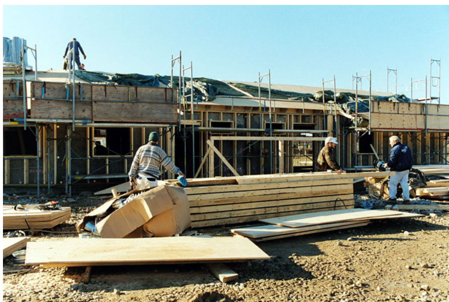
Figur 7. Tagkrydsfineren var afdækket frem til det tidspunkt, hvor tagappen blev lagt.
