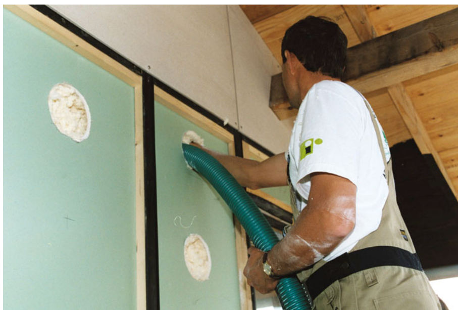
Figur 43. Træfiberisolering lægges i vægelementerne via en slange, som ved hjælp af et lufttryk pumper det findelte materiale frem.
