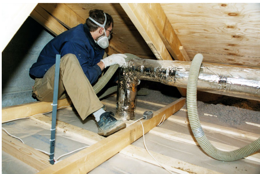
Figur 26. Indblæsning af Isodan som er løsfyldsisolering af cellulose. I forgrunden ses apparatur til måling af fugt og temperaturforhold monteret på den spredte forskalling.
