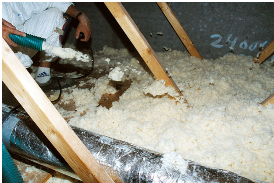
Figur 45. Træfiberisolering blæses ud på loftet og rettes af. Fødeslangen er ført gennem hoveddøren og trukket op gennem loftlemmen.
