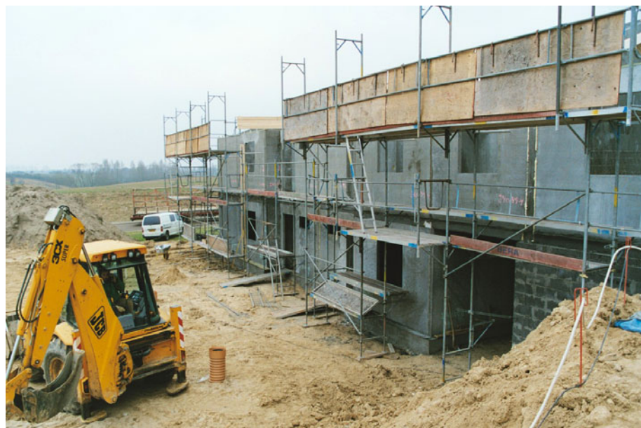
Figur 3. Længehusene er i den ene ende opført i to etager, der er adskilt af et præfabrikeret letklinker-dækelement.
