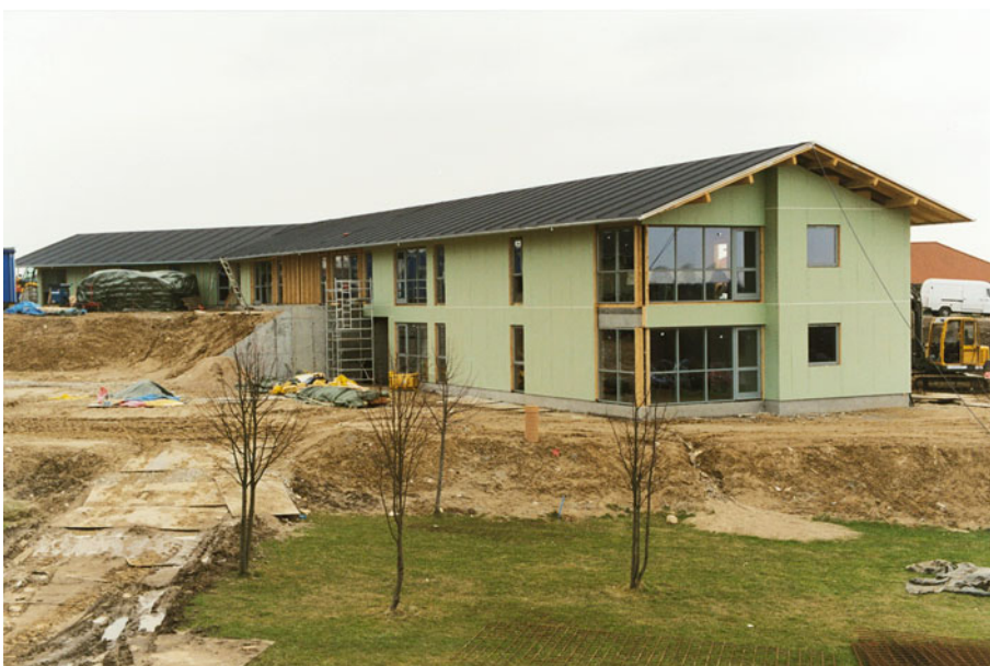
Figur 13. Facaden på længehusene lukkes med vindgips, underetagen, gavle og lejligheder isoleret med formstykker isoleres inden vindgipsen monteres.
