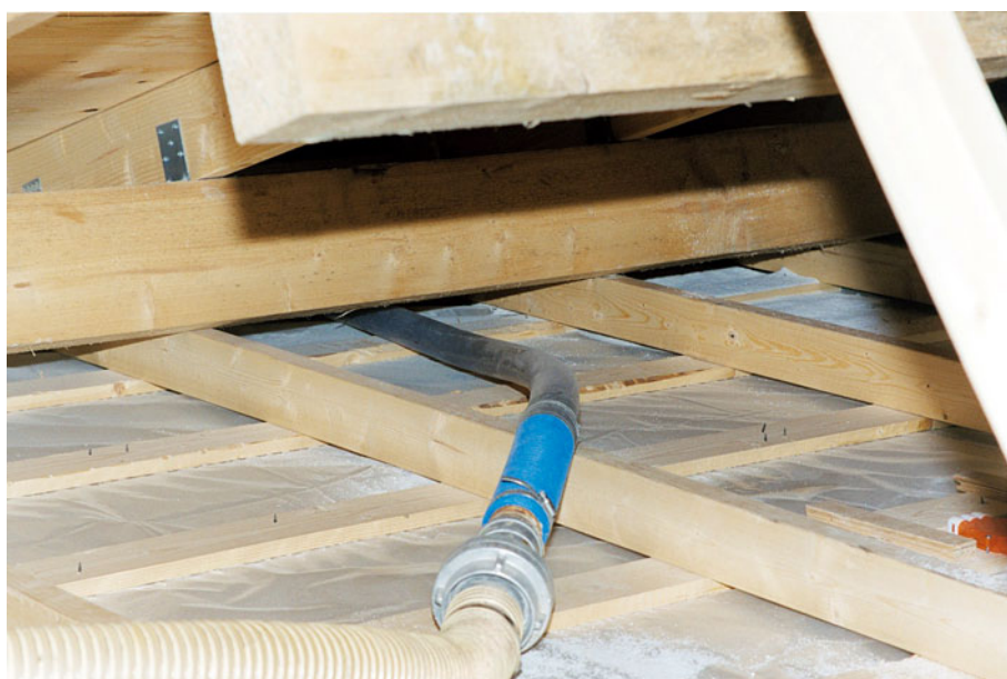
Figur 36. Perlite lægges i konstruktionen fra loftet via den åbne toprem. Slangerne trækkes gennem hoveddøren og op på loftet gennem loftlemmen. Perlite fordeles på loftet efter at væggene er blevet isoleret. Lukkede rum under vinduer i facaden fyldes med Perlite igennem et hul i sålbænken.
