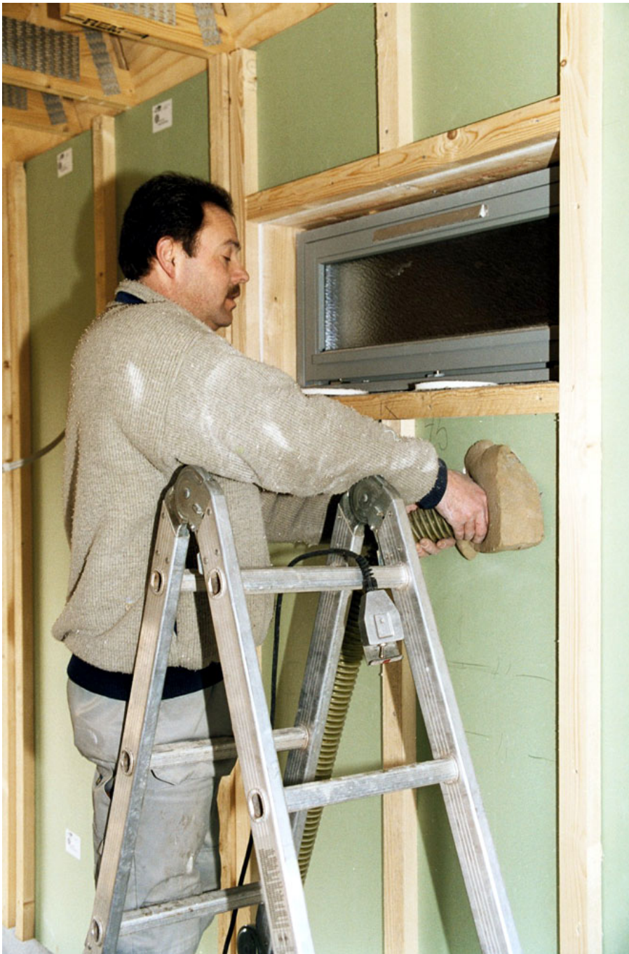
Figur 21. Lukkede rum, fx vægsektioner under vinduer, isoleres separat, ved at fødeslangen føres ned i væggen gennem et boret hul. Under isoleringen af vægsektionen trækkes slangen op og ud af hullet.
