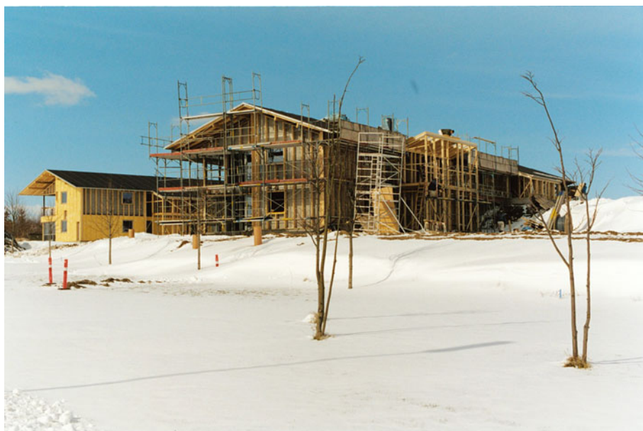
Figur 11. Efter at det første længehus er blevet lukket nedtages stilladset. Derpå lukkes længehus nummer to.
