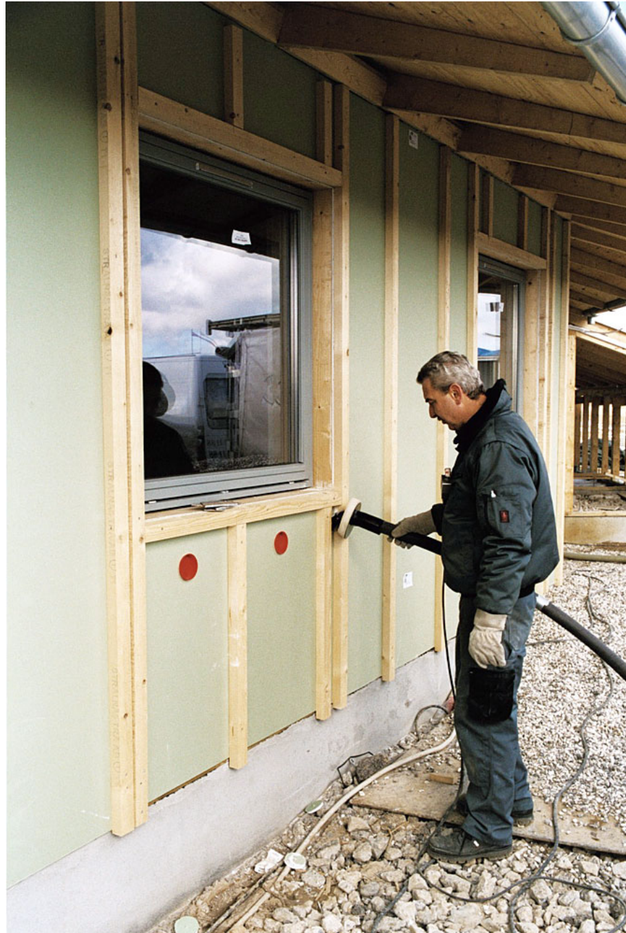
Figur 22. Isolering af et lukket hulrum under et vindue. Polyuretanskum udformet som en cirkulær plade er monteret direkte på indblæsningsslangen og bruges til at nedsætte støvbelastningen omkring isolatøren under indblæsningen.
