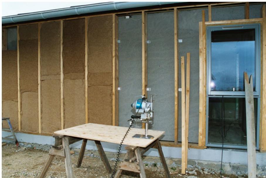
Figur 49. Tilskæring af hørmåtter foretages med en elektrisk sav, som man normalt anvender til at skære tekstiler med.
