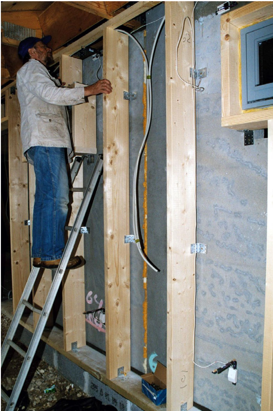
Figur 15. De enkelte "nodes" forbindes serielt i et elektrisk kredsløb.
