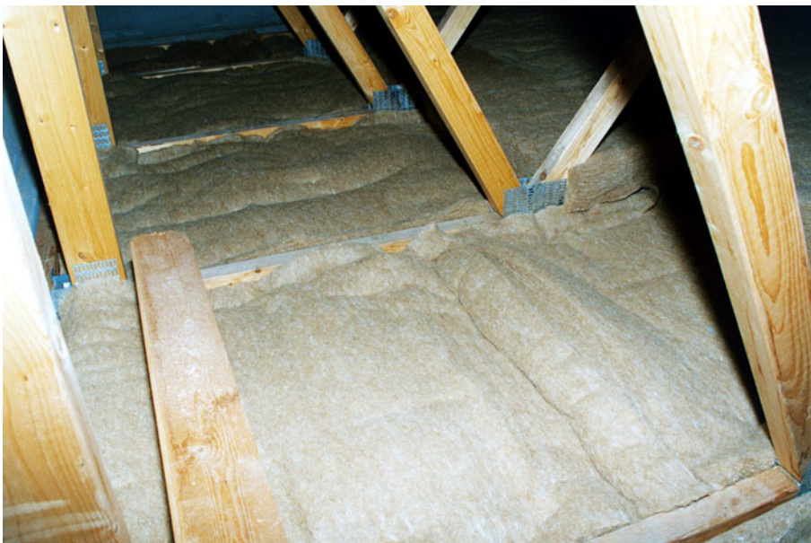
Figur 51. Loft isoleret med hørmåtter.
