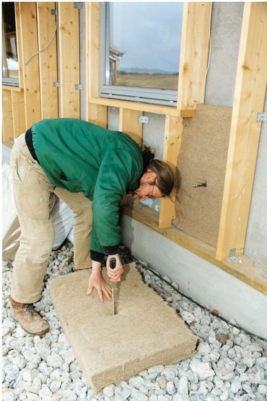
Figur 32. Isoleringsmætter tilskæres og tilpasning foretages til det opsatte måleudstyr.
