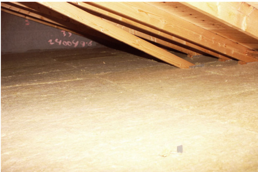
Figur 41. Loft isoleret med Rockwool batts.
