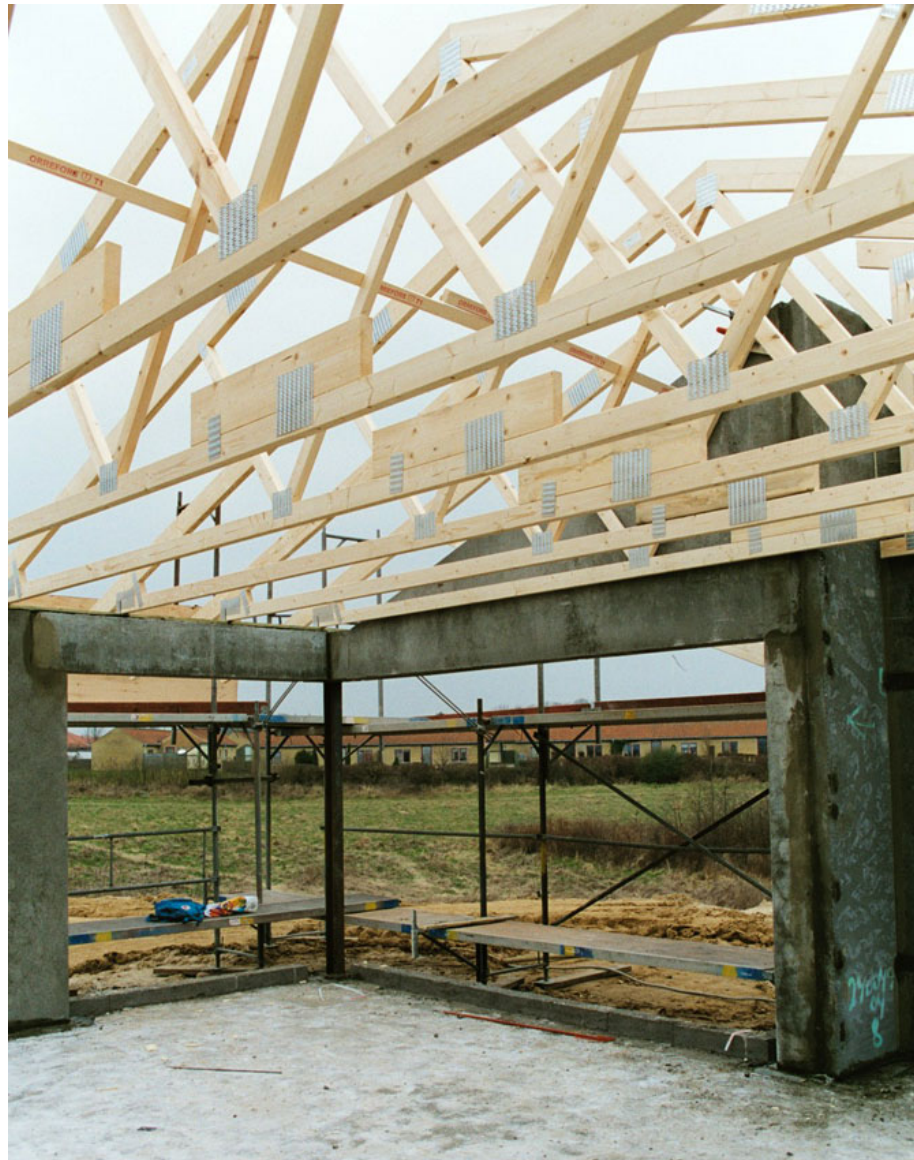
Figur 2. Gitterspærerne hviler af på bagvæggen.
