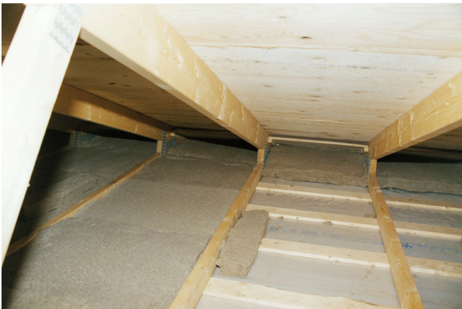
Figur 30. Første lag hørmåtter lagt ud på loftet.
