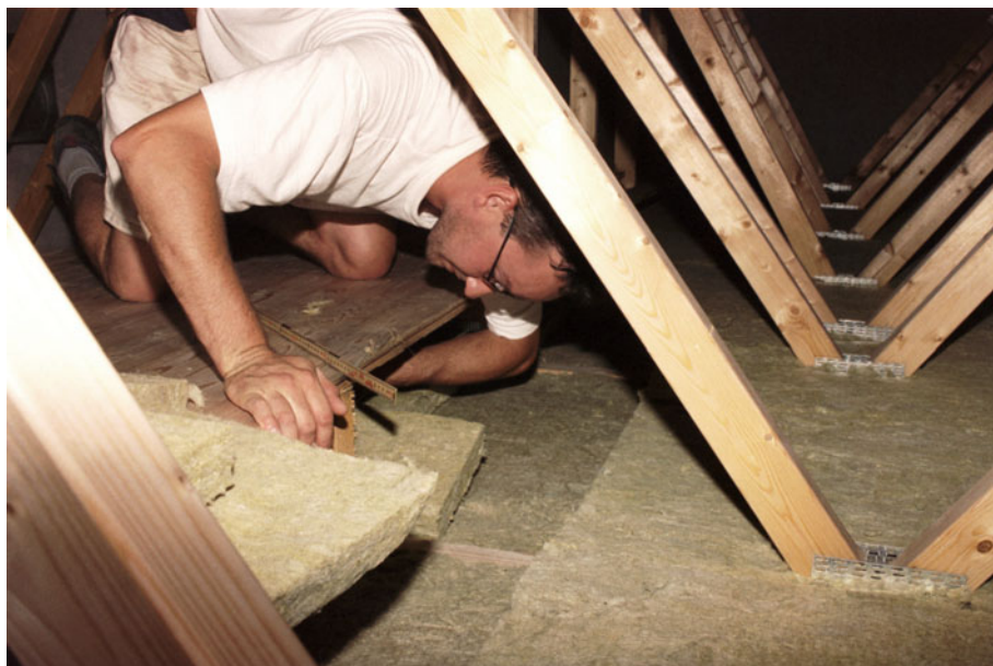
Figur 40. Isoleringen rettes til på loftet over lejlighederne.
