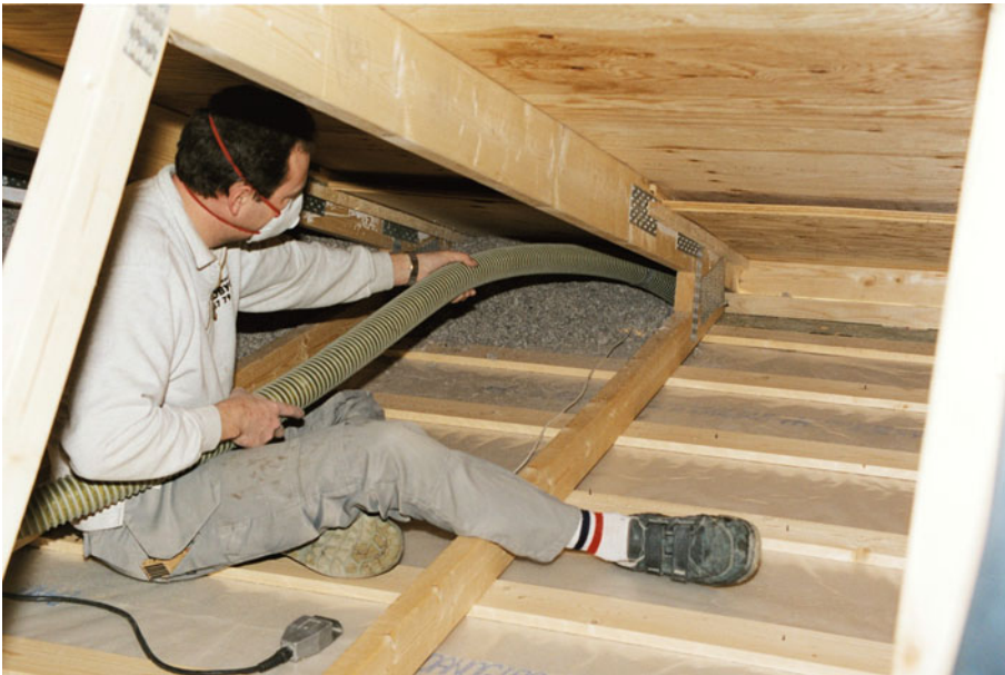
Figur 18. Den enkelte vægsektion isoleres ved at føre fødeslangen ned i bunden af væggen og gradvist at trække slangen op i takt med opfyldningen.
