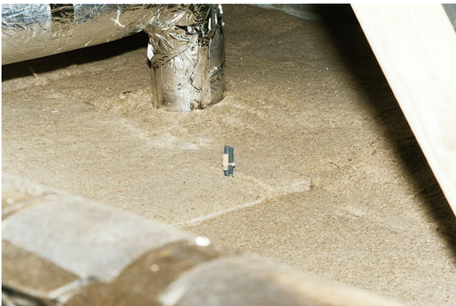
Figur 31. Isoleringmåtterne tilskæres og tilpasses loftets installationer. Her ses isoleringen tilpasset en rørgennemføring. Endvidere ses et målepunkt, inden det trykkes ned til lige under niveau med isoleringens overside.
