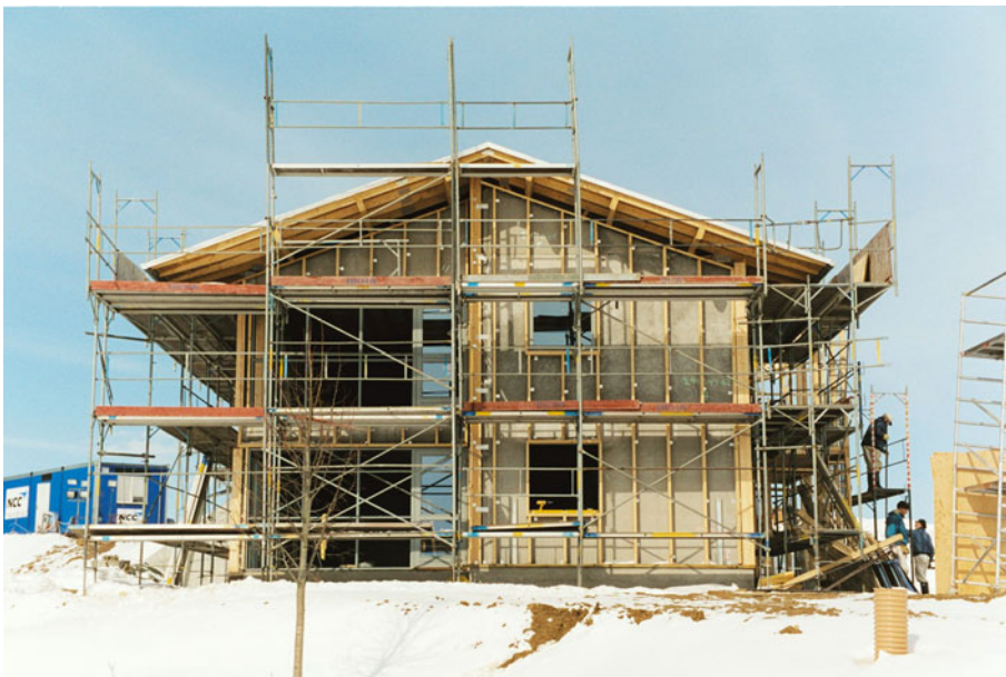
Figur 9. Efter færdiggørelsen af taget lukkes huset ved isætning af vinduer og døre.
