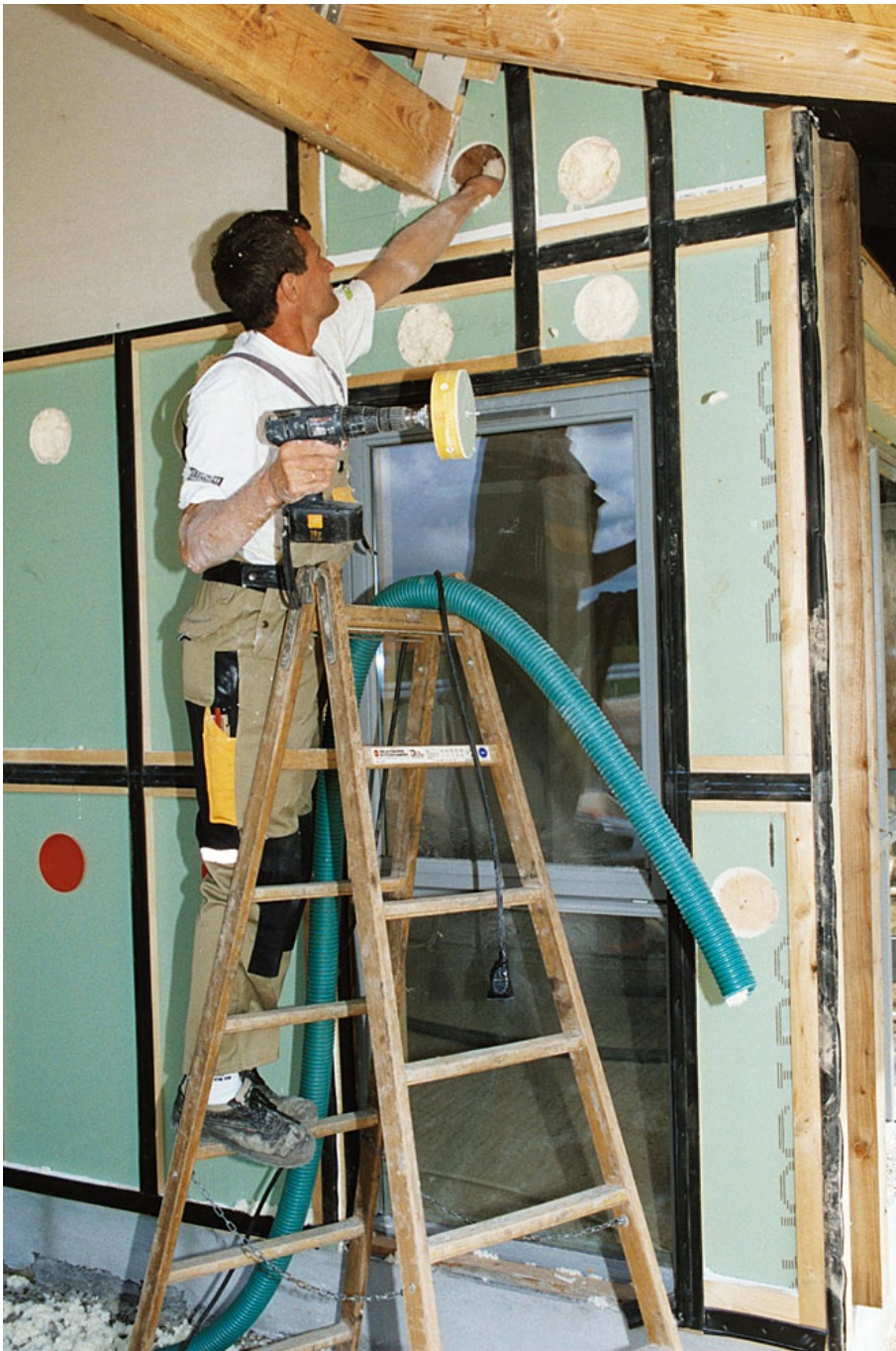
Figur 44. Mindre hulrum isoleres både med fødeslange og ved håndkraft.
