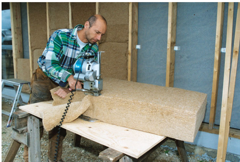
Figur 50. Tilskæringen af hørmåtter foretages på byggepladsen.
