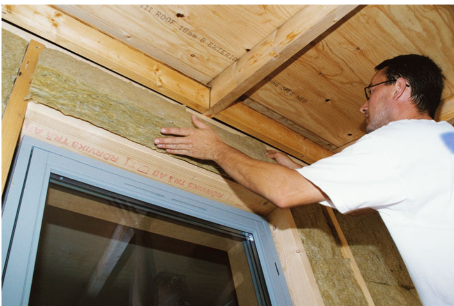
Figur 42. Facaden isoleres udefra inden vindgipsen sættes op.
