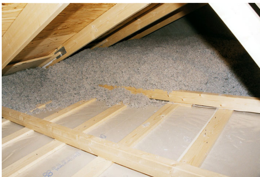
Figur 20. Loftet isoleres efter at de enkelte vægsektioner er blevet isoleret. Isoleringsmaterialet blæses løst ud på loftet. Vægsektionernes åbne toprem sikrer forbindelse mellem isoleringen i væggene og på loftet.
