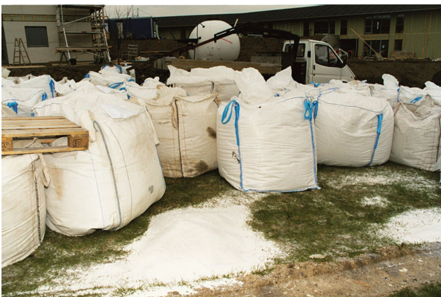
Figur 34. Perlite leveres i sække som håndteres med en mobilkran.
