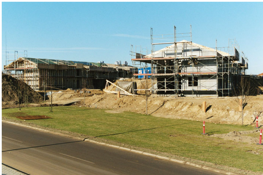
Figur 6. Råhuset til længehus nummer to påbegyndes umiddelbart efter færdiggørelsen af råhuset til det første længehus.
