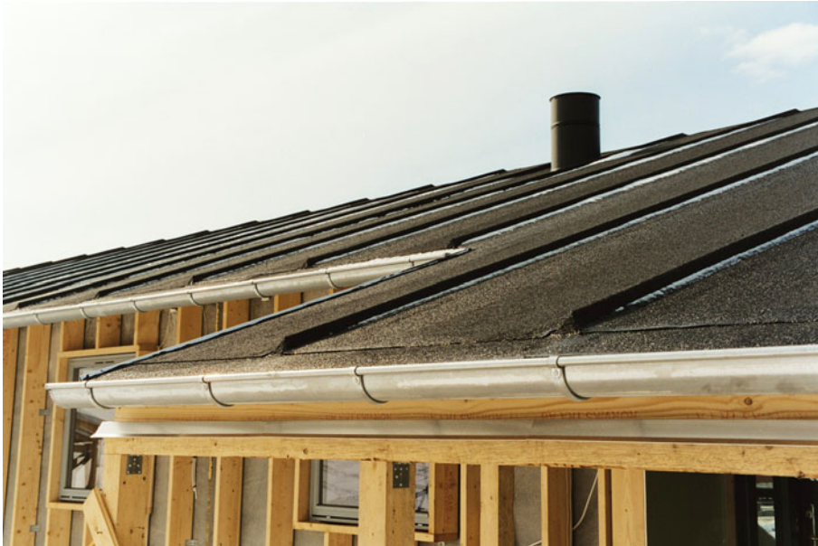
Figur 8. Den vandfaste pladebeklædning forsynes med trekantlister forud for lægningen af tagpappen. Kantlister og tagrender monteres samtidigt, således at huset kan lukkes og er tæt.
