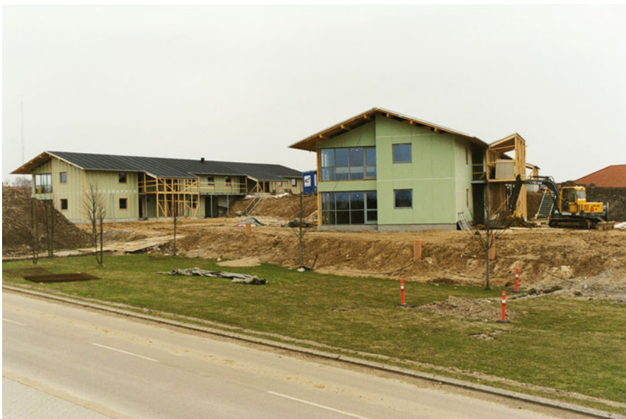
Figur 12. Længehusene beklædes med vindgips, hvorefter isoleringsprodukter af løsfyld kan indblæses.
