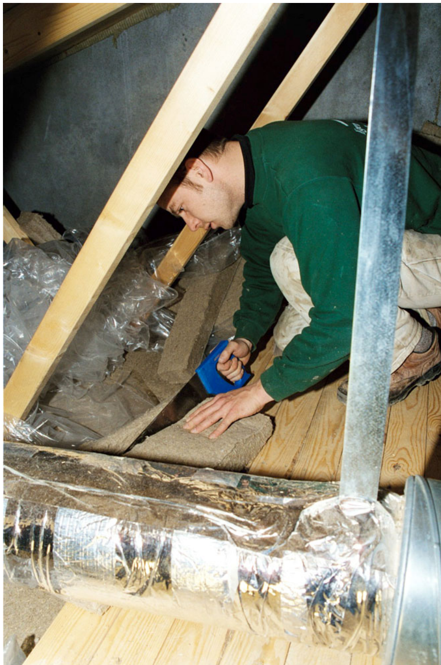
Figur 29. Isoleringsmætter af hør blev på stedet skåret til med en sav.
