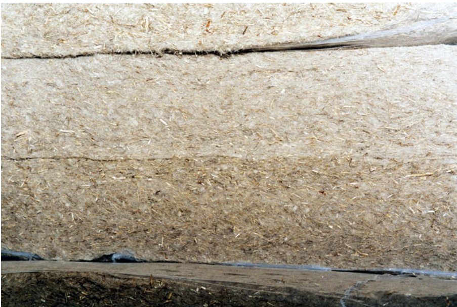
Figur 28. Et nærbillede af de anvendte isoleringsmåtter af hør.
