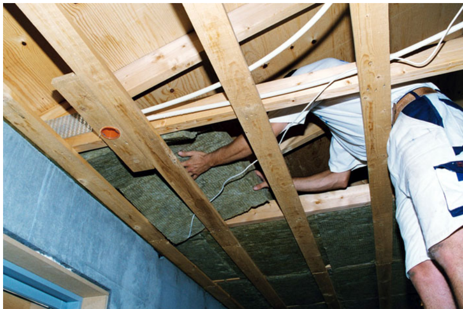
Figur 39. Rockwool batts tilskæres og monteres inden loftplader af gips sættes op.
