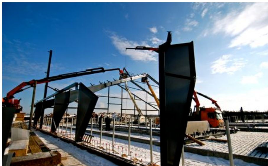
Figur 15. I efteråret blev stålbuene til den nye kostald rejst for byggeriet Vejlskovgård, Odder.
