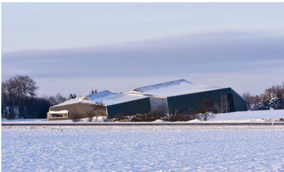
Figur 5. Den færdige lagerhal til korn og frø med maskinhus på Hulehøjgård, Veksø.
