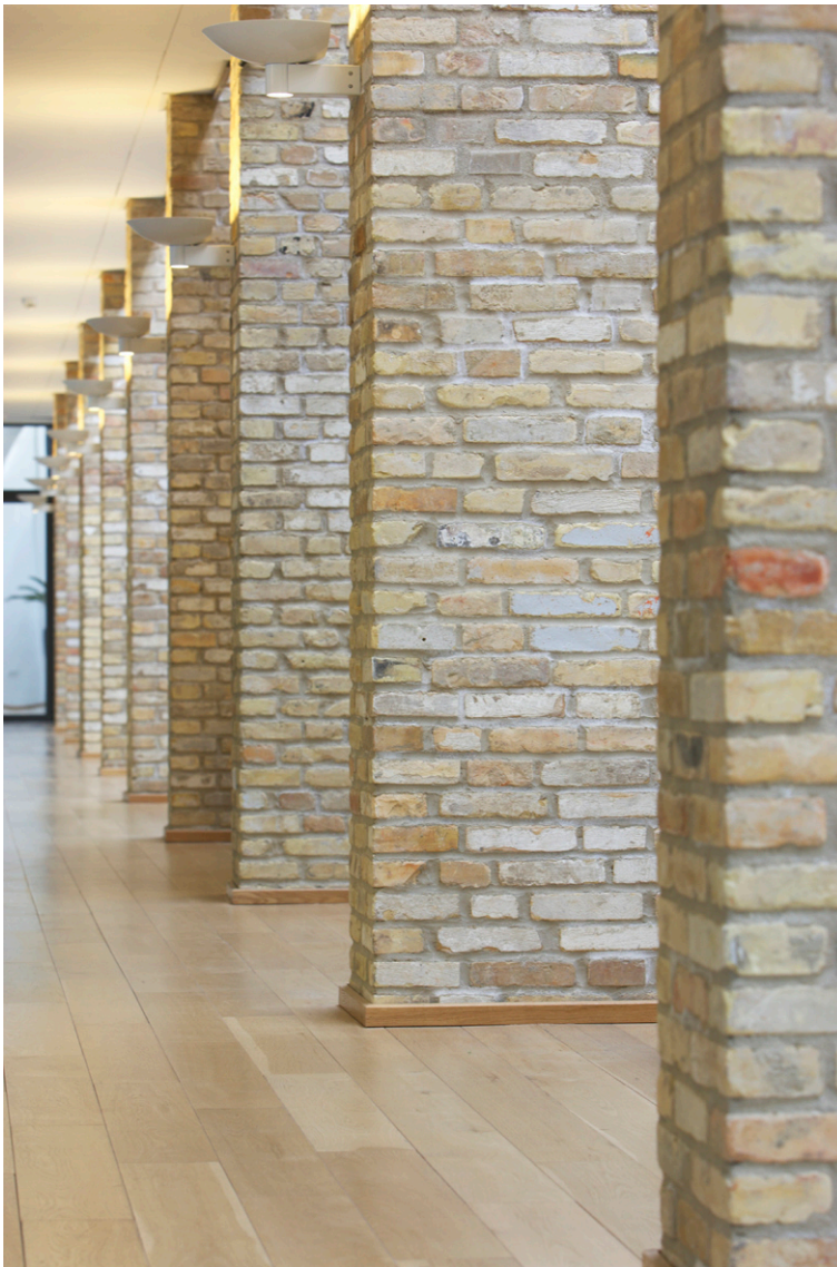
Figur 3. Illustration af murværk opført med genbrugsmursten.
