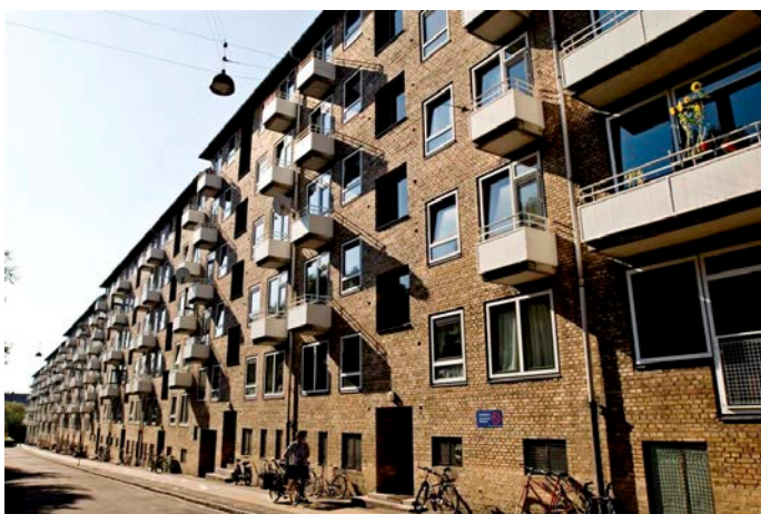
Figur 29. Eksempel på boligbebyggelse fra 1930-erne, her FSB-bebyggelsen Degnegården, hvor det er svært at gøre noget ved facaderne, bortset fra udskiftning af vinduer.
