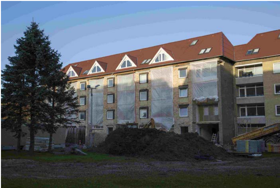
Figur 5. Bygningen under renovering (Foto: Boligforeningen Vesterport).
