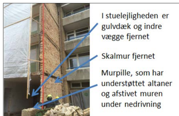
Figur 7. Bygning med angivelse af fjernede bygningsdele (Foto: (NCC Construction, 2014c) med tekst tilføjelse af SBI).
