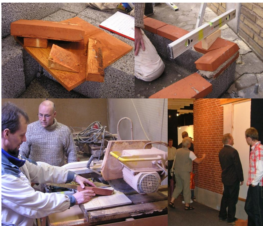
Ved udvikling af 'den takkede væg' på eksperimentariet hos EUC-Nord blev der udarbejdet en skæreskabelon til hjørnesamlinger og en skabelon til fiksering af stenenes hældning på 30 grader. (Foto: EUC-Nord)
