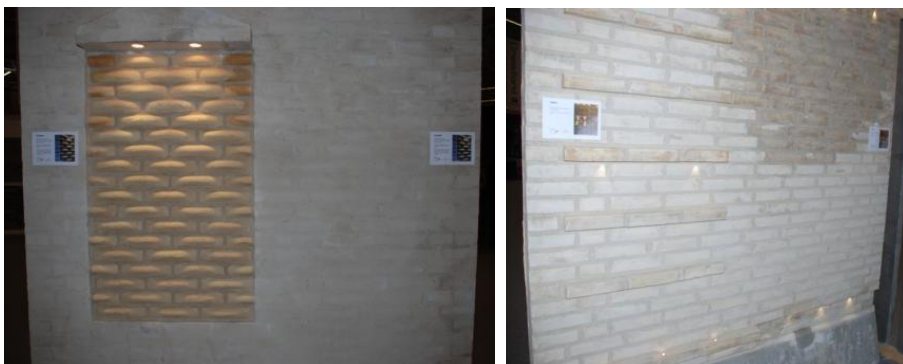
Indvendigt murværk med nye dekorative effekter og med indbyggede lysledere udført på EUC-Nord og udstillet i Herning Messecenter i 2008. (Foto: EUC-Nord)
