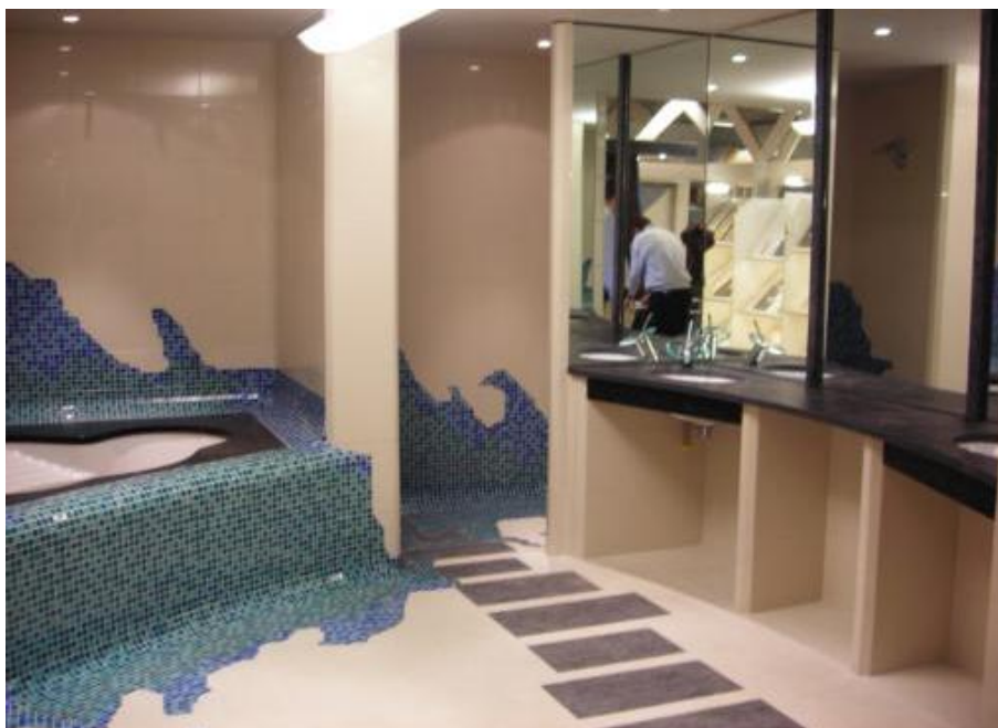
Dekorativt badeværelsesmiljø med afrundede overgange fra spabad og i bruseniche og med utraditionel indretning udført på eksperimentarium på EUC-Sjælland.
