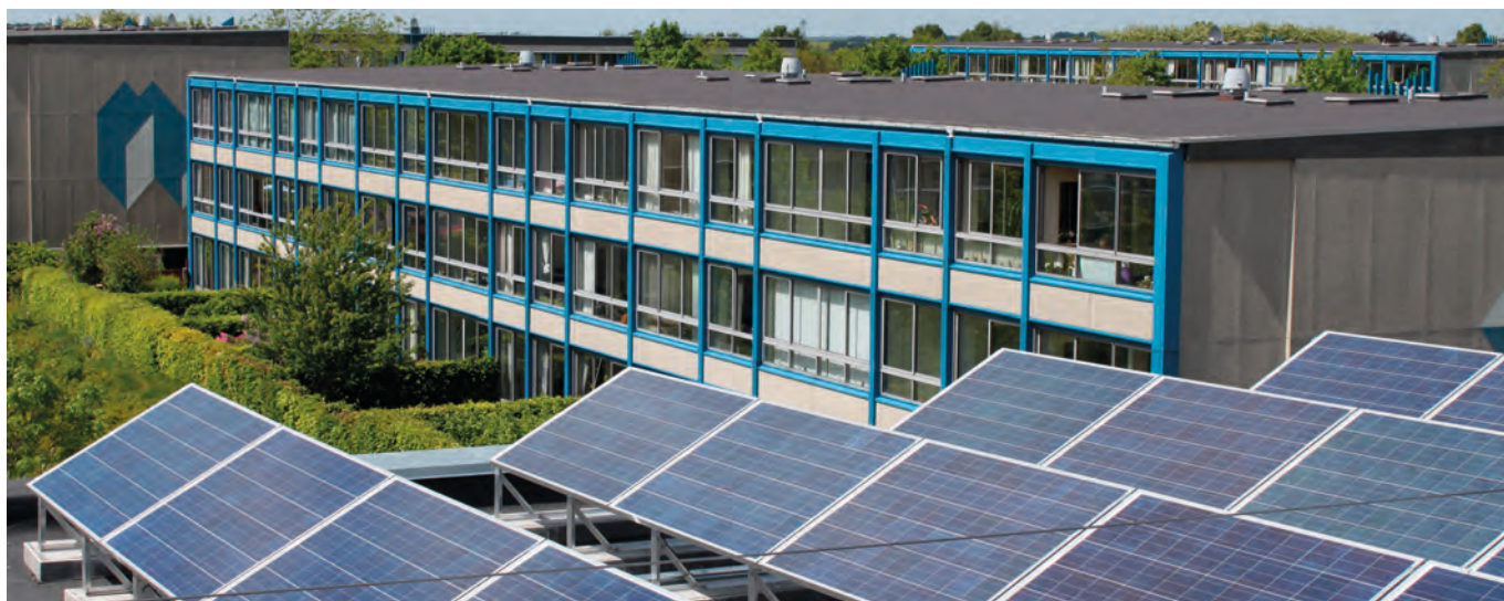
Solceller og solfangere på Klimablokken.
