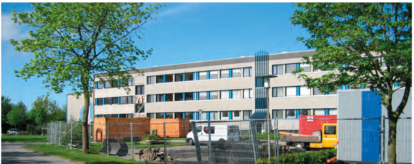
Klimarenovering af blok 1 - opstart.
