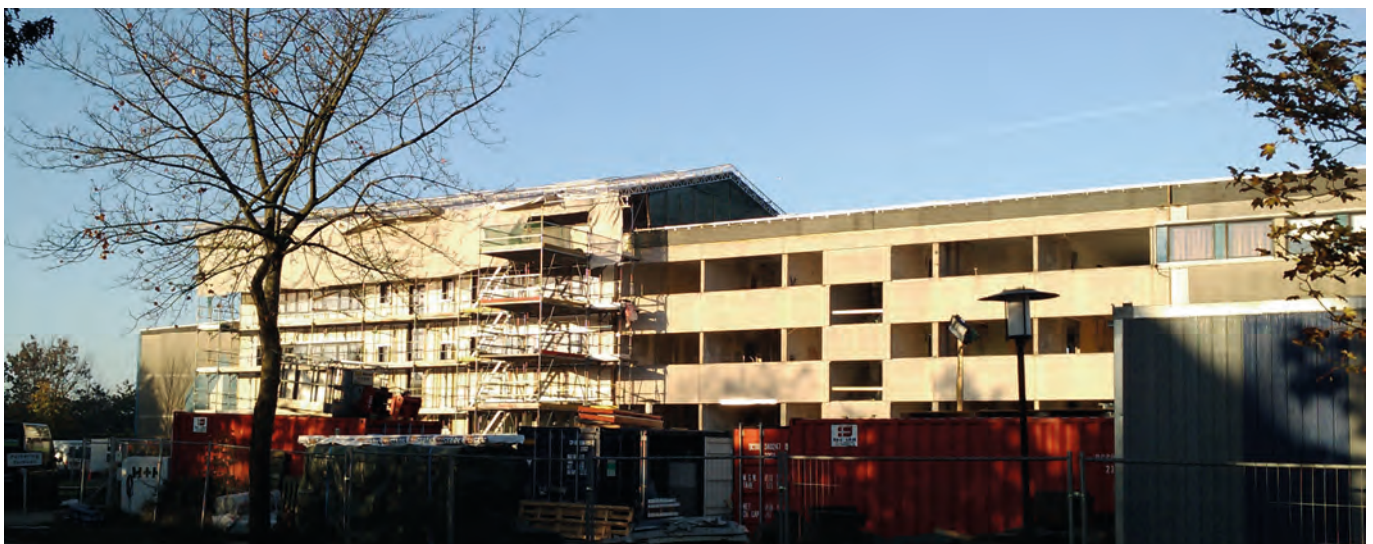
Klimarenovering af blok 1.
