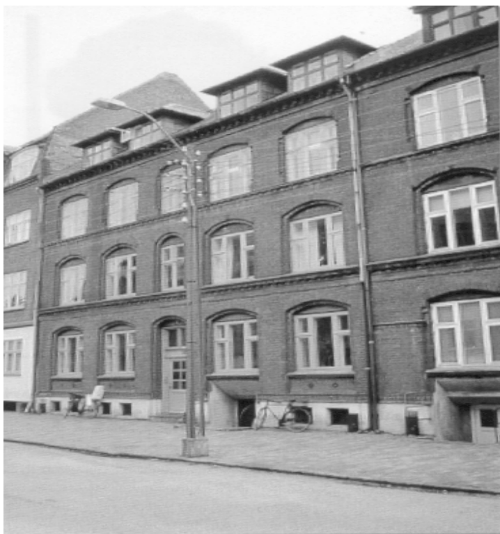
Figur 13. Gadefacade af Jagtvej 30, Odense efter renovering.
