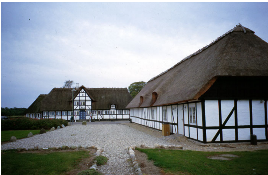
Figur 39. Vester Skerninge Kro, med den ombyggede krosal i længen til højre i billedet til et lokalt brugerhus med en kultursal til kulturelle arrangementer og udstillinger.
