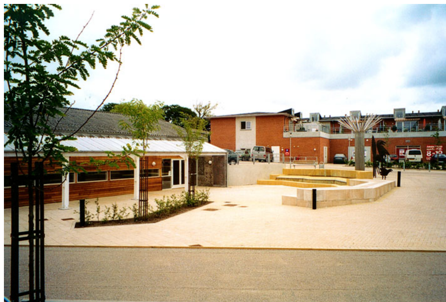
Figur 23. Torvepladsen med kunstudsmykning og siddemuligheder hvorimellem er placeret et vandarrangement. Petanquebanen skimtes i forgrunden. Torvehallen ses til venstre i billedet og den nye Dagli'Brugsen med boliger på 1. sal og parkeringspladser foran, ses i baggrunden.
