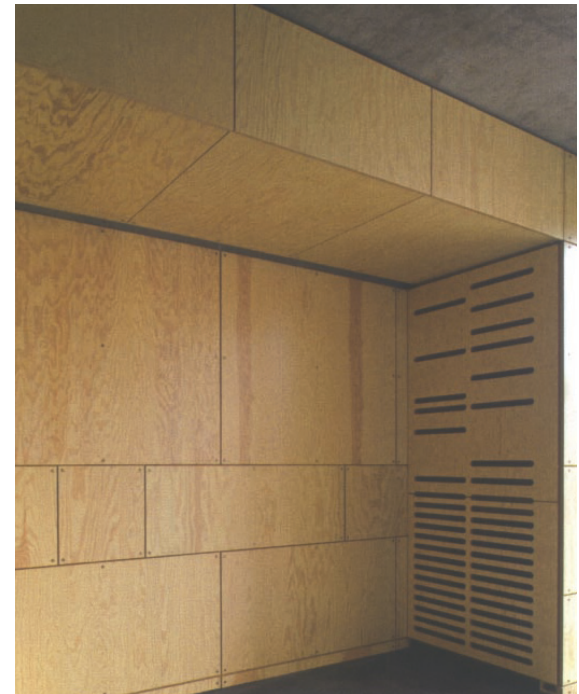
▲ Eksempel på hvordan vægelementet indeholder installationer, Tietgenskollegiet [Lundgaard og Tranberg]
