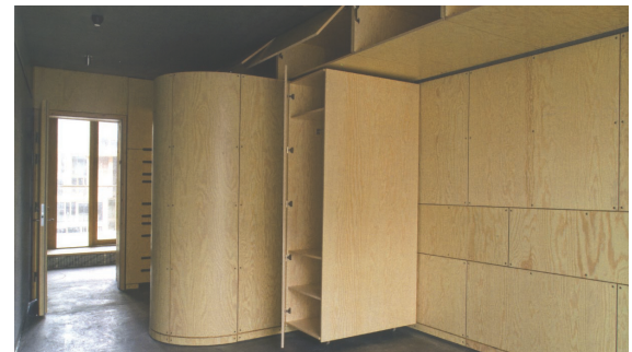
▲ Eksempel på vægelement i træ, der fungerer som opbevaring toilet med mere, Tietgenskollegiet [Lundgaard & Tranberg]
