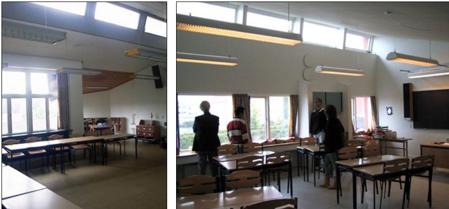
Figur 28. Hyltebjerg skole. En variation af det højsiddende vindue, hvor udsigtsvinduet er større end dagslysvinduet, og nichen kun udgør halvdelen af rummets længde. Afstanden mellem vinduesbåndene er her så stor, at kontrasten mellem mellemstykket og vinduerne ofte kan føles ubehagelig (blænding).
