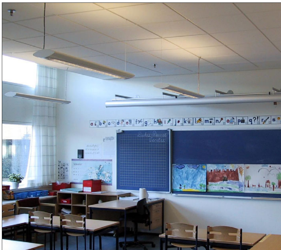
Figur 79. Forsøgslokale 1.11 mod syd. Lokalet har 9 stk. opad-/nedadlysende armaturer, der er opdelt i 3 grupper, som styres via en fælles føler monteret ud for de højsiddende dagslysvinduer.
