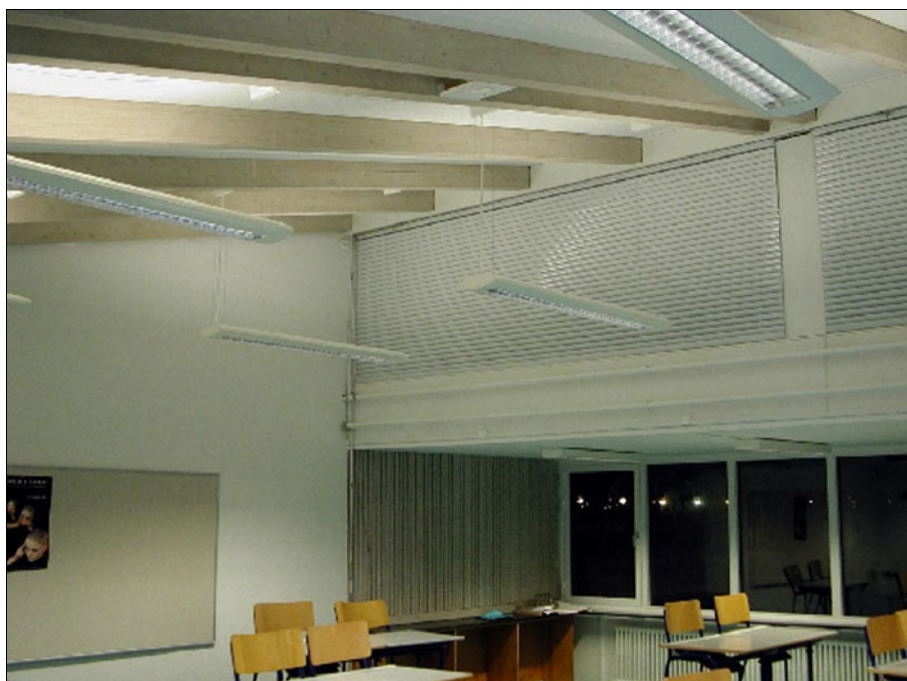
Figur 67. Den nye almenbelysningsanlæg består af ialt 9 armaturer med nye energieffektive, dæmpbare lysstofrør.
