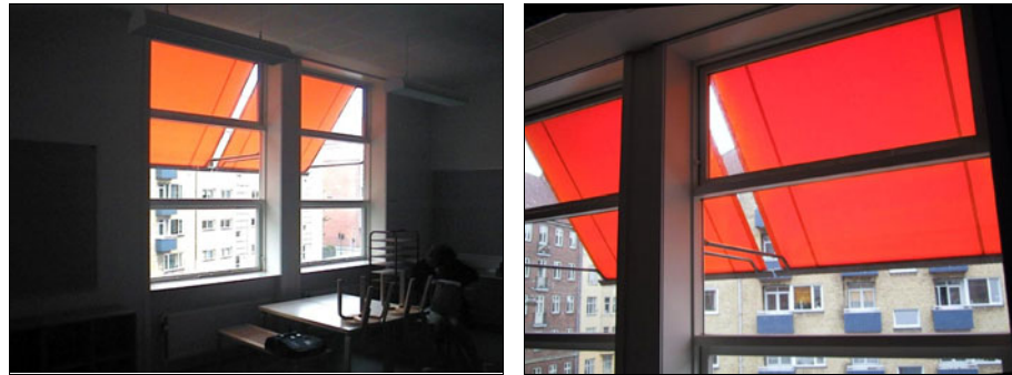
Figur 43. Rådmandsgade skole. På nogle af de gamle skoler i København anvendes markiser som solafskærmning. Løsningen er relativt billig og god, sammenlignet med andre udvendige løsninger. Markiser kan dog ikke anvendes, når det blæser kraftigt, og i visse tilfælde kan det være et problem, at de tillader direkte sollys at passere i de åbne trekanter og i mellemrummet mellem to markiser.
