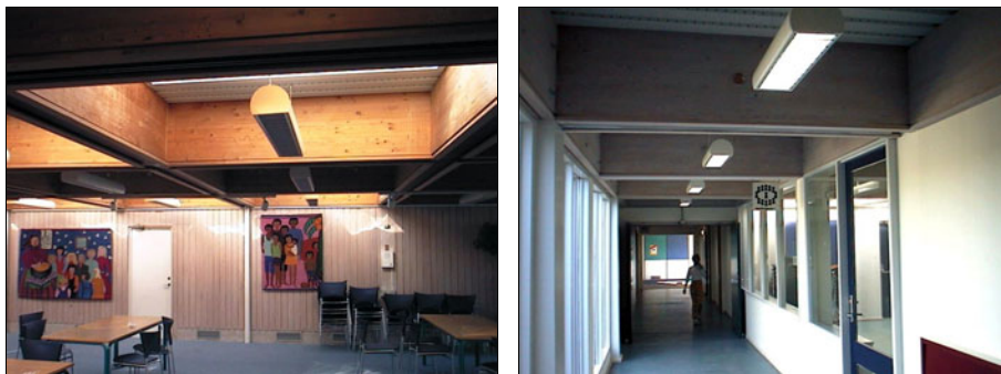
Figur 18. Stavns Holt skole. Ovenlys placeret uhensigtsmæssigt, efter skolens oprindelige udformning. Skaktvirkningen i ovenlysene forstærkes af de høje limtræsdragere, og dagslyset får en udpræget lodret retning med dårlig formgengivelse af rumlige objekter. I andre områder af skolen har man givet limtræsdragerne en hvidpigmenteret maling samt malet øvrige detaljer lysere, hvilket giver en blødere lysfordeling samt forbedrer det visuelle indtryk væsentligt.
