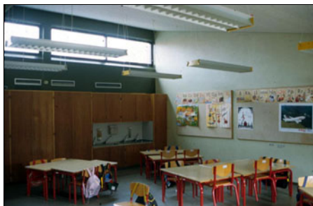
Figur 32. Højsiddende dagslysvinduer og udsigtvinduer i klasseværelse på Sønderbro skole, København. Det diagonale lysindfald bevirker, at der kun er få steder i lokalet, som ikke modtager dagslys.
