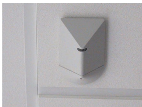
Figur 82. Dagslysføler på loftet i referencelokalerne.
