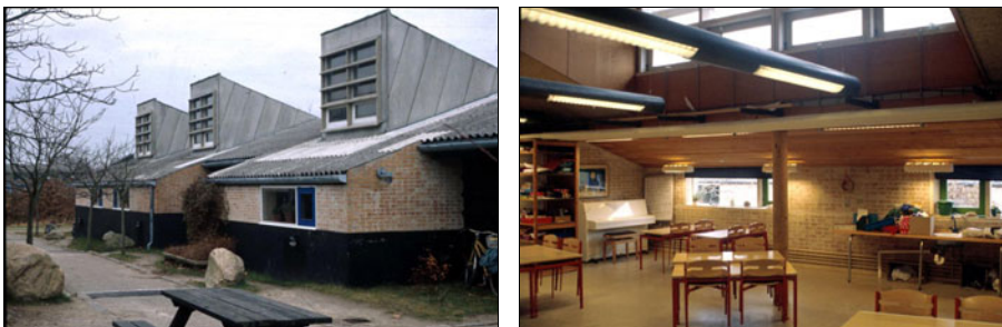
Figur 29. Stenvad skole. Hjemklasseområder med ensidigt dagslysindfald fra dels et stort højsiddende 'kvistvindue', dels nogle mindre udsigtsvinduer og en glasdør. På trods af det ret store vinduesareal forekommer dagslysniveauet utilstrækkeligt i flere områder af lokalet.
