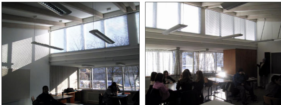
Figur 45. Billeder fra de to lokaler på Tingbjerg skole som er renoveret og har fået opsat persienner. Persiennene er lette at justere, og de giver mulighed for en mangfoldighed af lysindfald efter det aktuelle ønske og behov.
