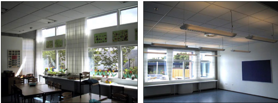
Figur 15. Hedegaardsskolen. I lokalerne mod vest (højre billede), har man valgt ikke at lade det nedhængte loft gå helt op til betondækket, og derfor optræder det faste parti ikke på denne facade.
