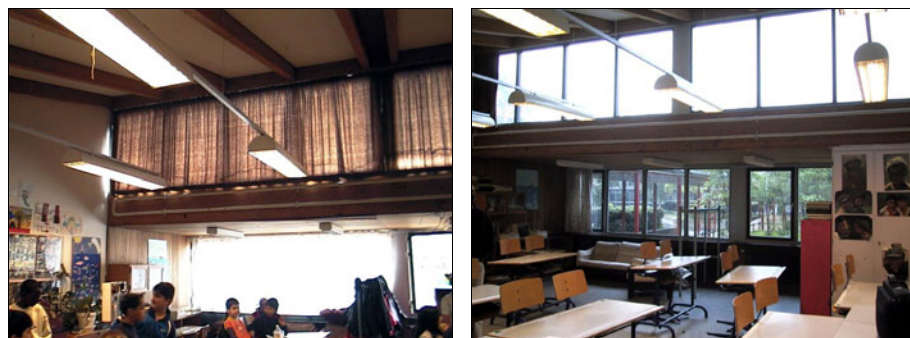
Figur 44. Tingbjerg skole, eksisterende klasserum. Kun en del af klasselokalerne har gardiner for de højtstående vinduer, og der optræder et næsten permanent problem med blænding. I klasselokaler, som har gardiner, er disse ofte trukket permanent for, således at dagslyset langt fra bliver som tilsigtet.
