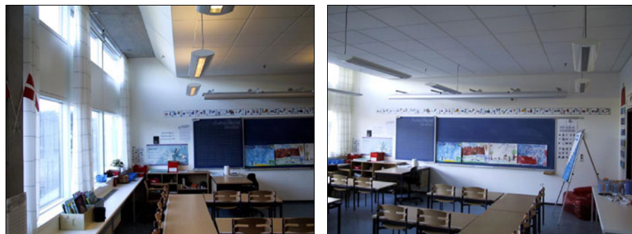
Figur 14. Hedegaardsskolen. Lyset kastes dybt ind i rummet fra de højtstående dagslysvinduer. Blænding fra himlen reduceres ved at de to vinduestyper er forsynet med uafhængige solafskærmninger.
