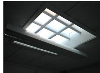
Figur 21. Egebjerg skole, Snit og detalje af ovenlys. I forbindelse med en renovering af skolen blev en del af ovenlysene forsynet med kraftigt solafskærmende lameller. Disse forekommer unødigt kraftige, idet de reducerer lysindfaldet meget betydeligt.
