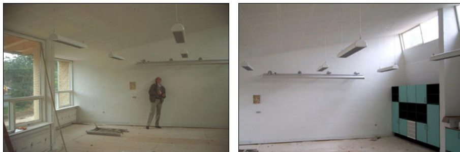
Figur 33. Vinduesvæg og højt placerede vinduer i klasseværelse i Kirsebærhavens skole. De lyse flader omkring det højtstående vinduesbånd blødgør kontrasten mod den lyse himmel.
