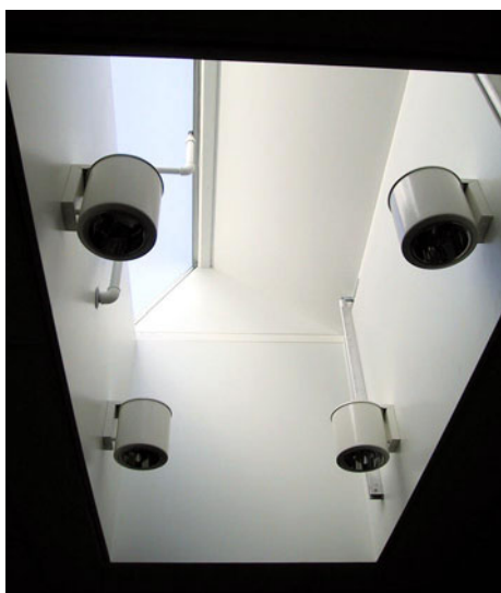
Figur 19. Ovenlys på Hedegaardsskolen. Selv på de nye skoler ses det ofte, at belysningsarmaturer placeres i ovenlysene, hvilket kan reducere dagslysindtaget betydeligt.
