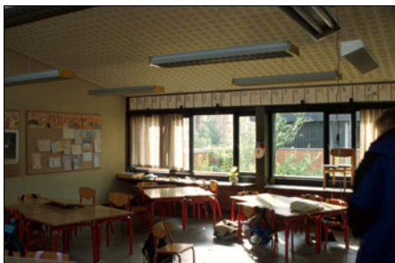
Figur 32. Højsiddende dagslysvinduer og udsigtvinduer i klasseværelse på Sønderbro skole, København. Det diagonale lysindfald bevirker, at der kun er få steder i lokalet, som ikke modtager dagslys.
