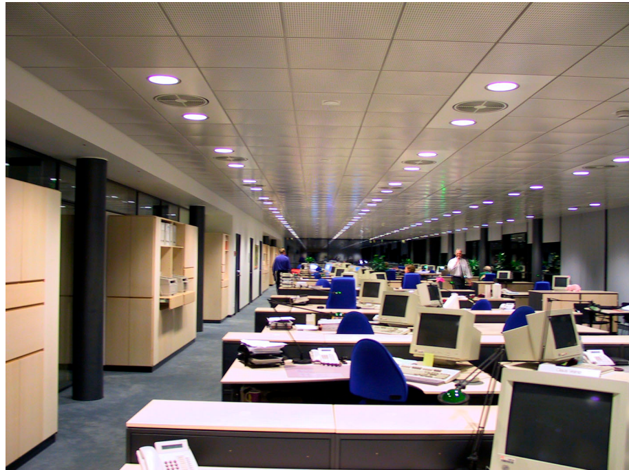
Figur 5. Lyset bør komme ind fra siden i forhold til arbejdspladserne, som vist på billedet. Herved minimeres spejlinger og reflekser i papirer på bord og i tastaturer.
