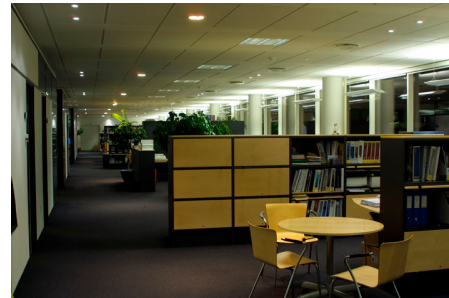
Figur 25. De opadlysende armaturer giver meget lyse pletter på loftet. Det virker imidlertid "rigtigt", da lysindfaldsretningen er som om dagen, hvor der er meget dagslys ind gennem vinduerne.
