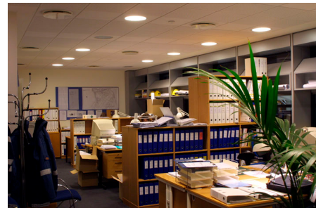
Figur 31. De indbyggede armaturer fordeler lyset godt, men den opale afskærmningsplade har en for høj luminans, der kan svække billedet i pc-skærmen.
