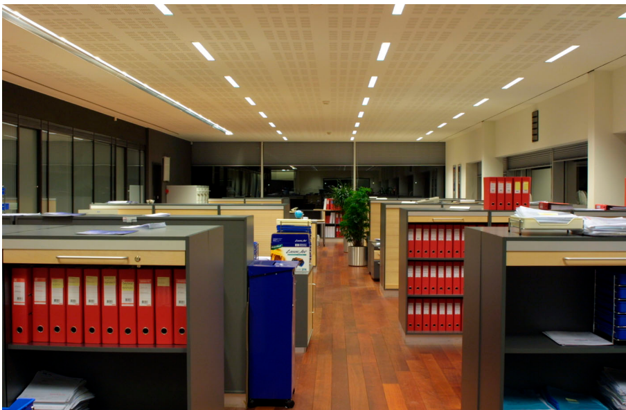
Figur 1. NEG-Micon: Direkte belysning fra nedadlysende armaturer med dobbeltparabolisk afskærmning.
