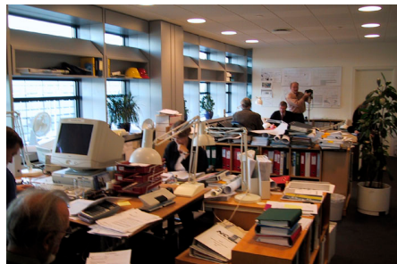
Figur 30. Den specielle vinduesudformning med en fralægningshylde midt i vinduesfladen virker bedst om aftenen, hvor den lyse hylde medvirker til at give en god lys- og luminansfordeling i lokalet.
