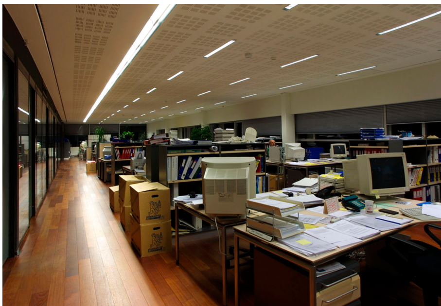
Figur 36. Det lange armatur, der følger ganglinjen, er meget dominerende og generer med spejlinger fra armaturet i uheldige vinkler.
