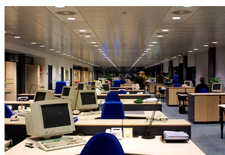
Figur 40. Om aftenen leveres almenbelysningen af planforsænkede downlights med en passende lysfordeling og en velreguleret afskærmning, der, uden at blænde, "fortæller", at lyset er tændt.
