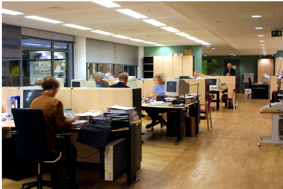
Figur 2. Nestlé Danmark: Direkte belysning fra delvist indirekte lysende indbygningsarmaturer.
