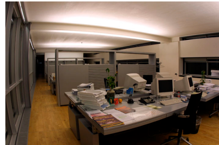
Figur 38. Den store afstand mellem lysrør og loft sikrer en stor spredning af kunstlyset og en lav luminans på det hvide loft.
