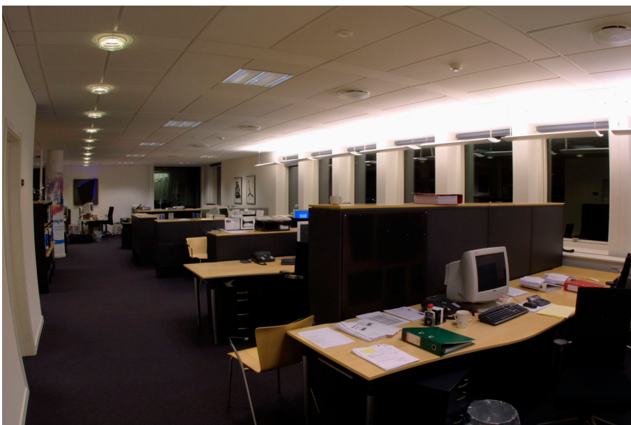
Figur 4. Philips A/S: Indirekte belysning fra nedhængte, opadlysende armaturer.
