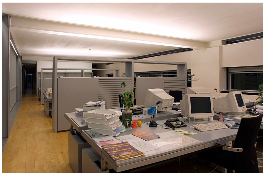
Figur 13. Den jævne lysfordeling skyldes bl.a. brugen af armaturer, der på samme tid er direkte og indirekte lysende.
