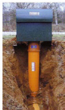
Figur 27: Eksempel på filteranordning ved luftindtag.
