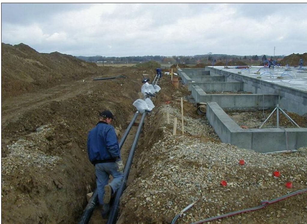
Figur 5-3 Fjernvarme til ny bebyggelse med korte stikledninger
