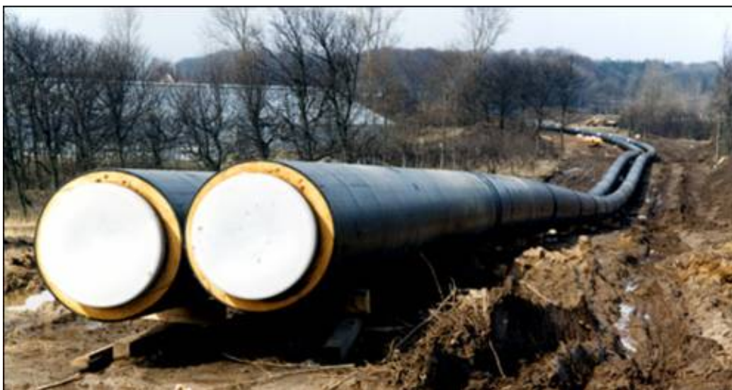
Figur 7-16 Fjernvarmetransmission over lange afstande
