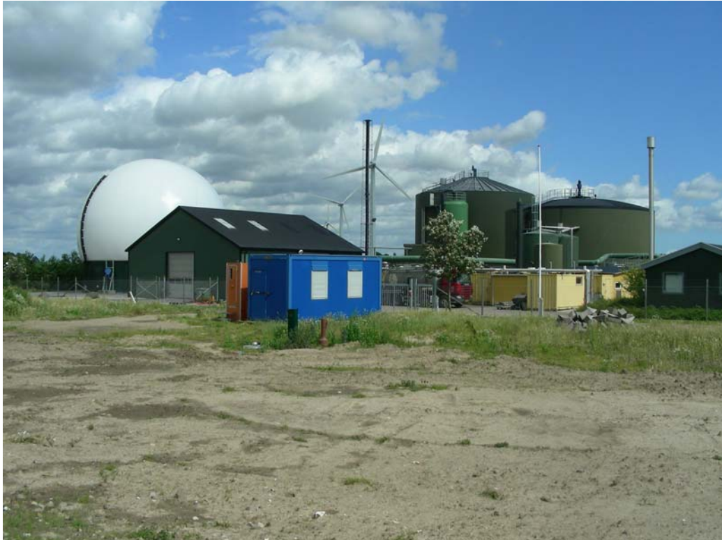
Figur 6-6 Hashøj Biogas producerer biogas til Hashøj Kraftvarme
