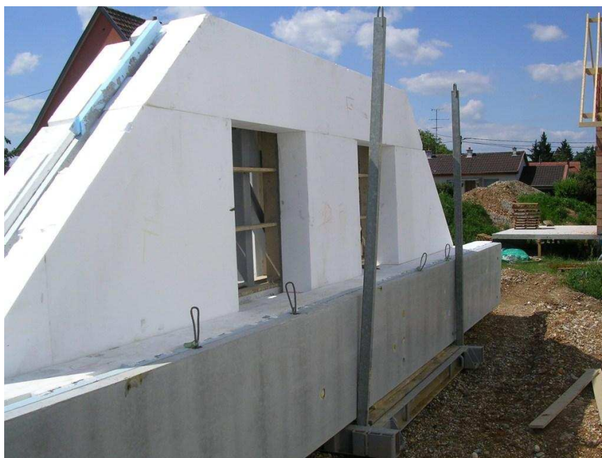
Figur 7: Præfabrikation og stærk ekstern isolering gør det muligt at opnå bedre energiprformance. (Foto: Frédéric Bougrain).
