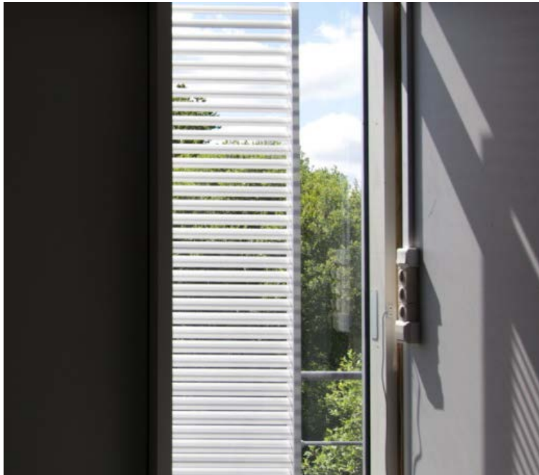
Figur 11. Energy Frames element med indbygget lamelafskærmning (persienne).
