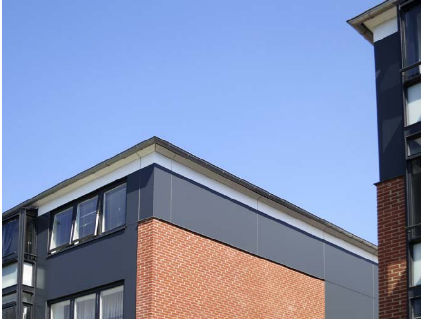
Figur 83. Pladebeklædning og murværk. Facaderne er en kombination af pladebeklædning og murede partier.
