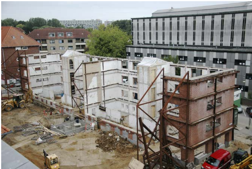
Figur 94. Bevaring? Der er ikke blevet revet bygninger ned i traditionel forstand, men stort set al indmad er fjernet, og hele den ene facade er nedrevet. Nye boliger er opført inden for rammerne af det, der stod tilbage.
