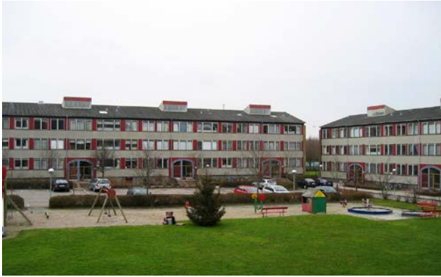
Figur 7. Byggeteknisk ambulancetjeneste. Lilletoften i Skovlunde blev i forbindelse med en renovering i 1990'erne beklædt med steni-plader. Resultatet ses til venstre. Til højre ses bebyggelsen efter den aktuelle renovering.
