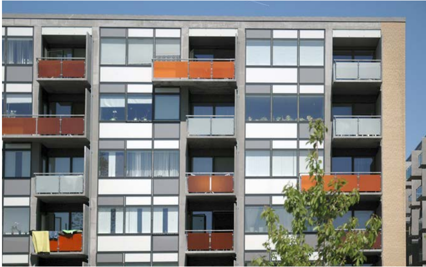
Figur 58. Nye altanfacader. Alle oprindelige altaner er revet ned og erstattet af nye og større altaner i fiberbeton.
