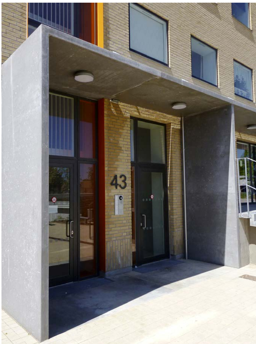
Figur 64. Indgange markeret både synligt og følbart. De nye overdækkede indgange og farverne signalerer allerede på afstand, hvor opgangene er. Betonsiderne og belægningen bidrager også til at markere dørene, som bygningsreglementet tilsiger.
