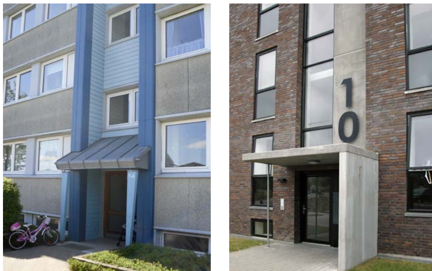
Figur 134. Indgangsparti før og efter renovering. Der er skabt en lægivende beskyttelse af indgangen, og nye glaspartier skaber godt dagslys i opgangen.
