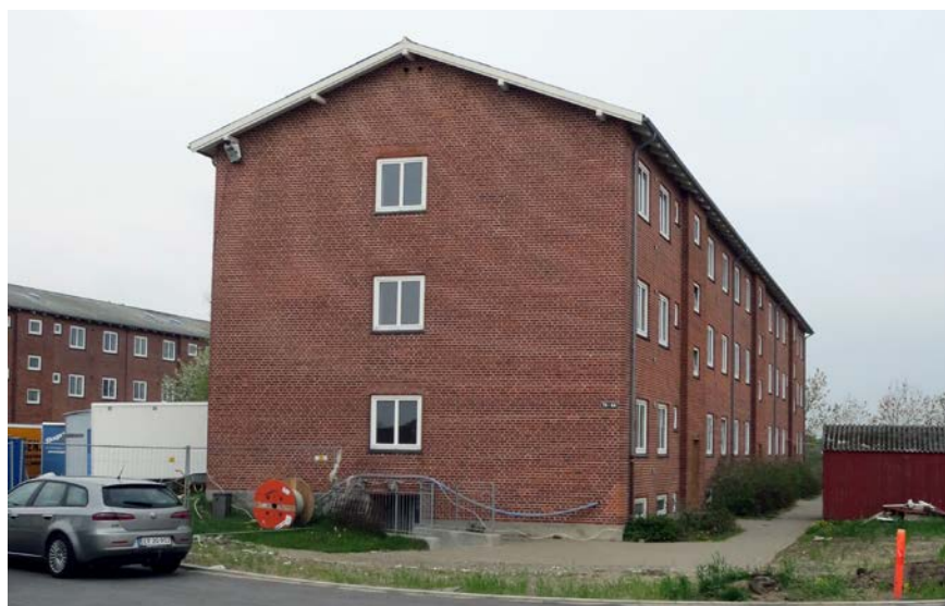
Figur 118. Boligblok før renovering. Husene, som de så ud umiddelbart før renoveringen gik i gang.
