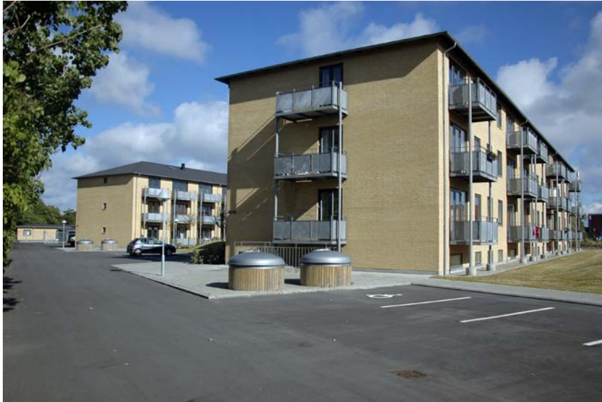
Figur 119. Boligblok efter renovering. Bebyggelse er blevet skalmuret med gule mursten. De galvaniserede altaner stammer fra en tidligere renovering i 1990'erne.
