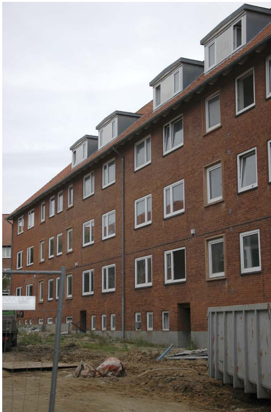
Figur 89. Ringgårdens indgangsfacader. Bebyggelsens indgangsfacader fotograferet under den igangværende renovering.
