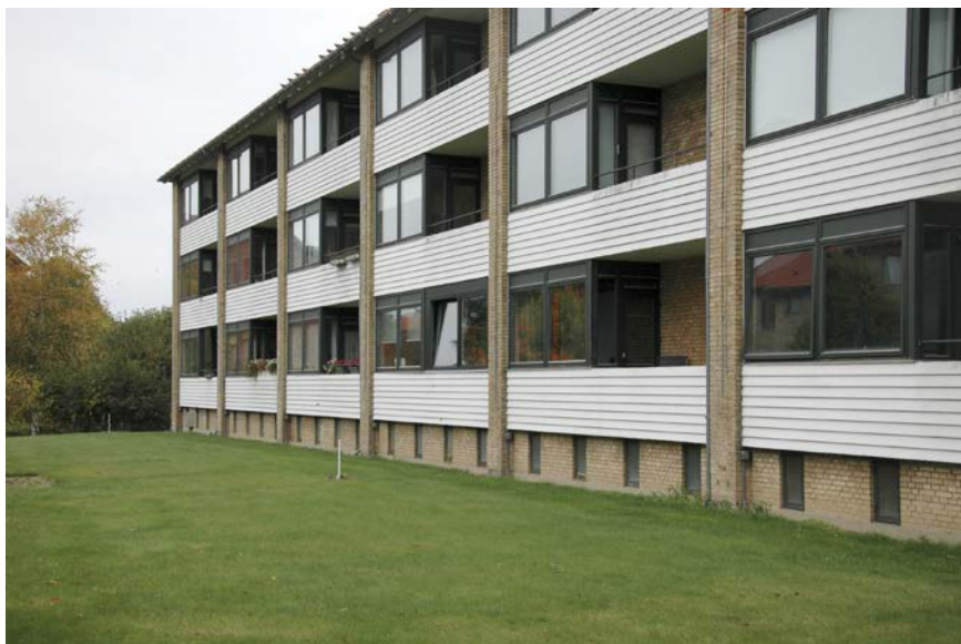
Figur 104. Slotsvængets friarealer før renovering. Altanfacaderne med de markante betonbrystninger. Udearealerne er triste, og det er ikke klart, hvem de er tiltænkt.
