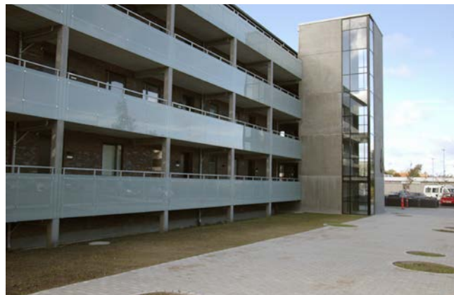
Figur 136. Adgangsforhold. De østvendte facader på to boligblokke, der tidligere var ens. Til venstre ses de nye vinduespartier, hvis nederste del er blændet. Til højre de ældreegnede boligblokke, der har fået en mere vandret struktur.
