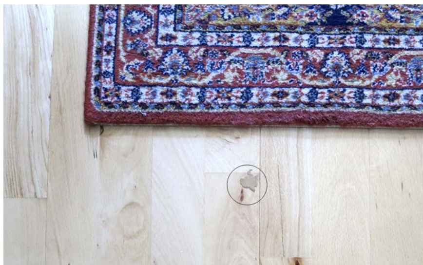
Figur 29. Reparation af parketgulv. Beboer i Parkvej finder den håndværksmæssige udførelse mangelfuld og reparation for grov.
