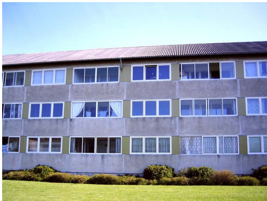
Figur 81. Havesiden før renovering. (Foto: Mangor og Nagel).
