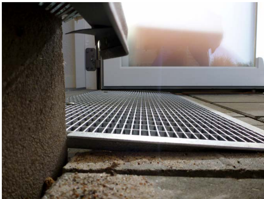
Figur 115. Skråtstillet rist, så døren kan åbnes. Med en udadgående dør hentes et par centimeter under dørbladet, så døren lettere kan åbnes, hvis der ligger lidt is, sne eller småsten.
