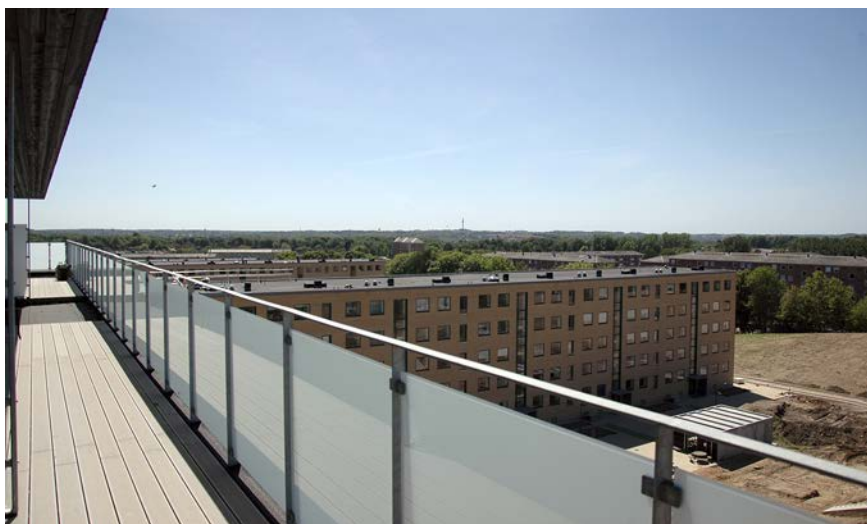
Figur 19. Nye boligtyper. Udsigten fra tagterrasserne omkring de nye penthouselejligheder i Finlandsparken.
