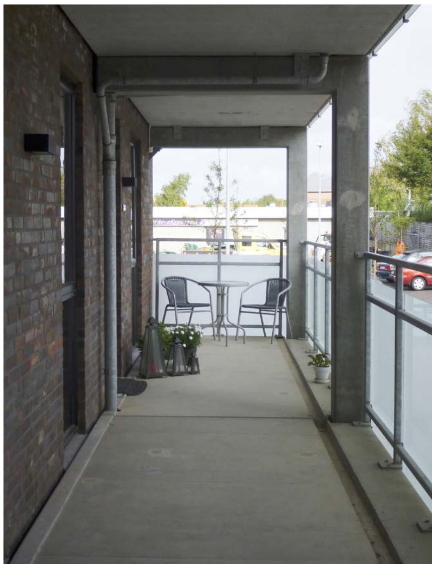
Figur 138. Brede altangange. De ekstra brede altangange giver flere muligheder end normalt, og gør det også let at vende med mobilitets-hjælpemidler.
