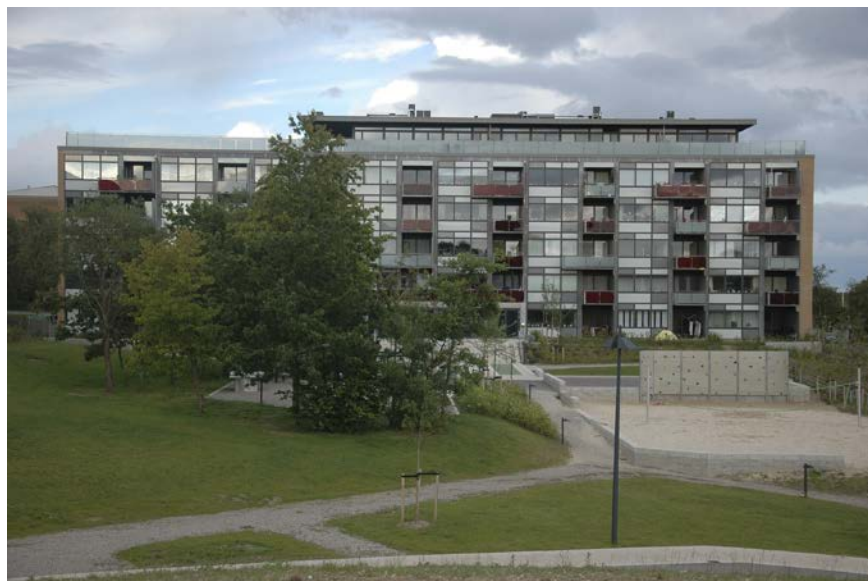
Figur 15. Penthouselejligheder i Finlandsparken. Finlandsparkens nye overetager skaber en fin afslutning på bygningerne.
