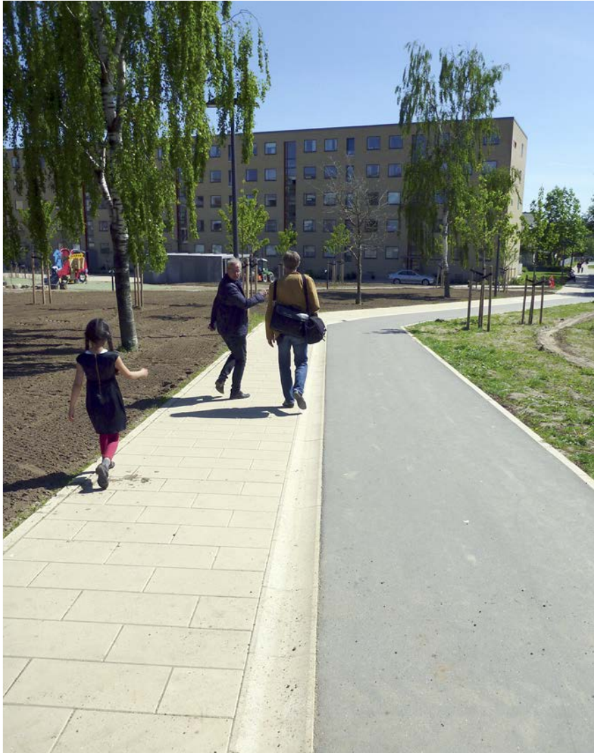
Figur 67. Adskillelse mellem gående og kørende. Fint eksempel på, hvordan Bygningsreglementet kan opfyldes på en enkel måde; her med en rende som følbart adskillelse på stiferløbet gennem bebyggelsen.
