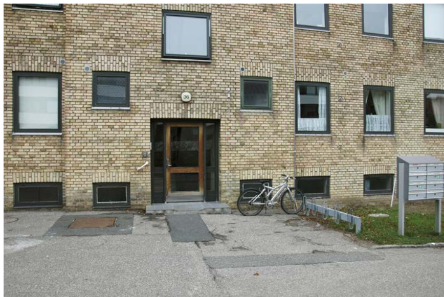
Figur 105. Indgangsfacader før renovering. Arealerne omkring indgangspartier. Renoveringen var ikke gennemført ved rapportens skrivning, derfor er der ingen illustration af situationen efter renoveringen.
