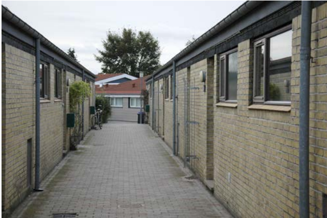
Figur 75. Bebyggelsens indgangsfacader – før og efter renovering. Bebyggelsen er oprindelig opført i gule mursten med bølgeeternit på tagfladerne. Facaderne er blevet efterisoleret og beklædt med skærmtegl, mens der i forbindelse med den aktuelle renovering ikke er gjort noget ved tagfladerne.
