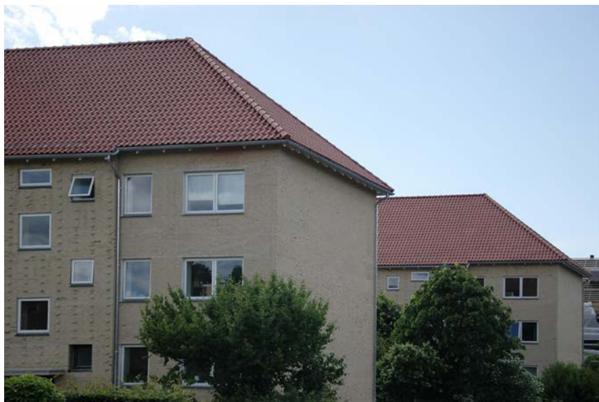
Figur 106. Tagfladerne. Tagenes udhæng med synlige spær er tidstypiske træk, der er blevet retableret. Der er samtidig blevet ryddet kraftigt op på tagfladerne, der tidligere fremstod med et rod af ovenlys, ventilationspiber mm.
