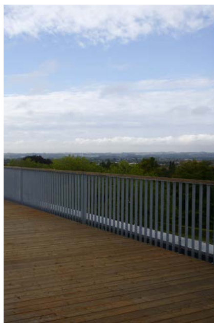
Figur 95. Udsigt både siddende og stående. På terrasserne er værnene forholdsvis transparente og gør det muligt at se ud og ned på omgivelserne, også hvis man sidder ned. Samtidig er de gjort sikrere for børn, fordi de lodrette balustre er svære at klatre på.
