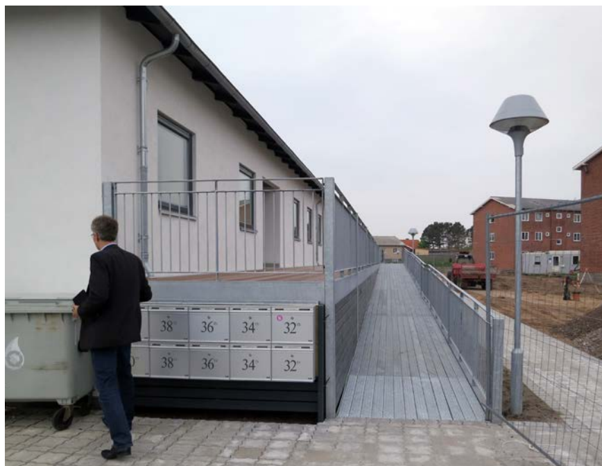
Figur 122. Indgangsparti til tilgængelige rækkehuse efter renovering. De røde blokke til højre i billedet er nu revet ned.
