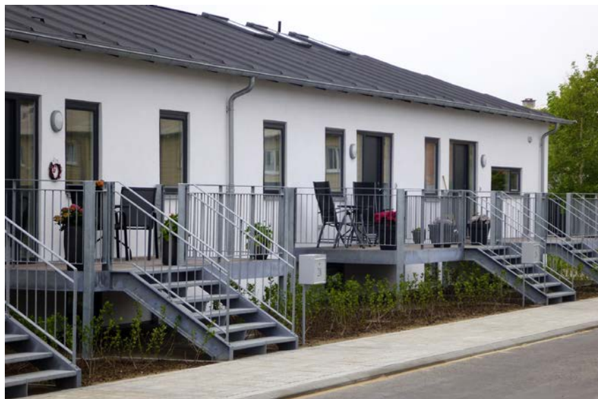
Figur 124. Rækkehuse efter renovering. Attraktive indgangspartier i rækkehuse.
