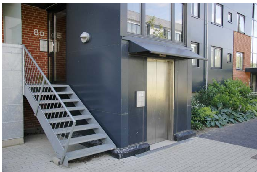
Figur 86. Udvendig opgangselevator. Elevatoren er et alternativ for personer med funktionsnedsættelser, som ellers skulle have brugt fx håndlister i begge sider og lukkede stødtrin på trappen for at komme op og ned.
