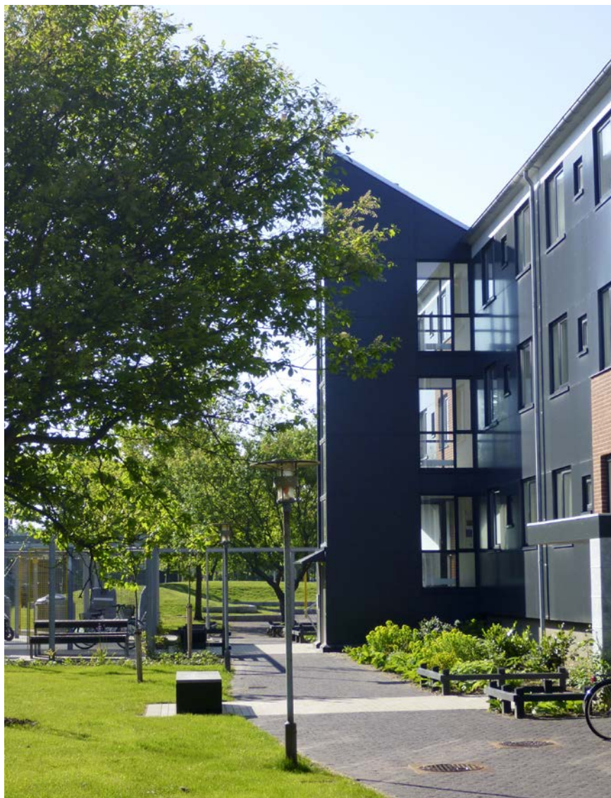
Figur 84. Elevatortårne. Nye elevatortårne skaber tilgængelighed, og store glaspartier trækker dagslys ind i opgangene.
