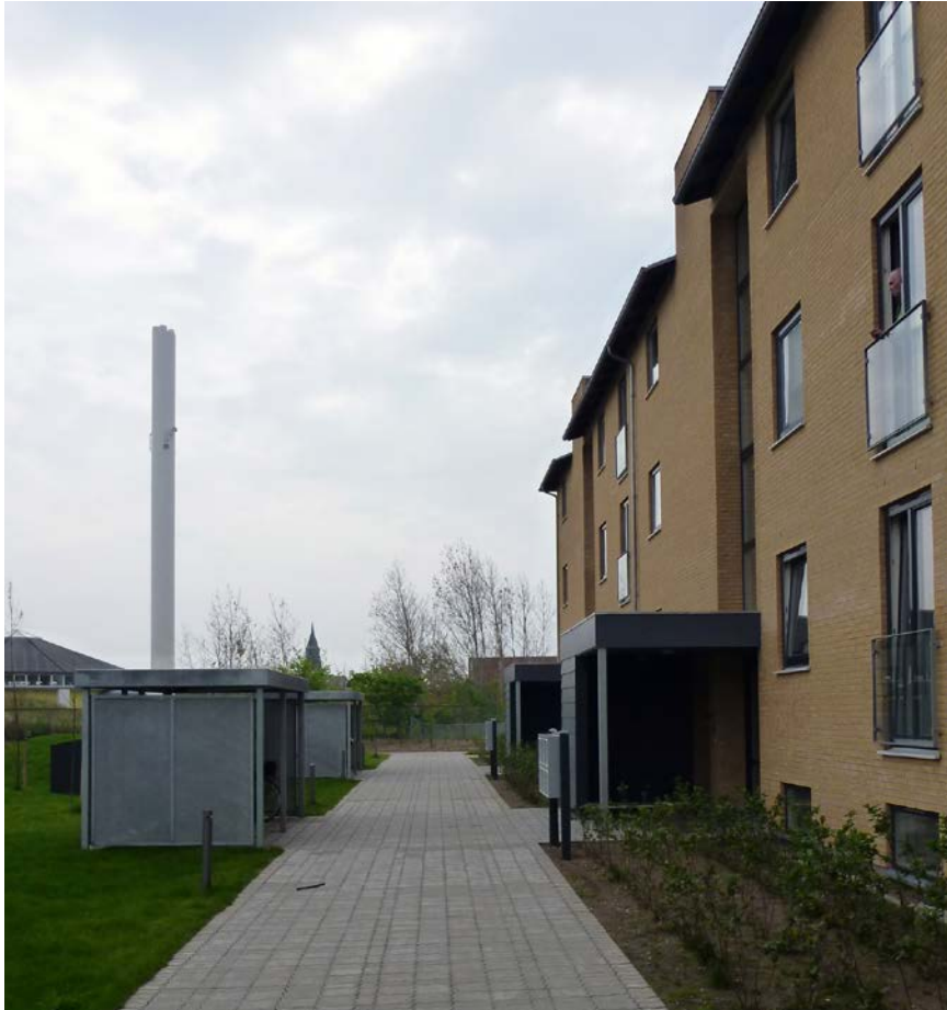
Figur 121. Indgangsfacade efter renovering. Indgangspartier efter den gennemførte renovering med dør til trappe og elevator.
