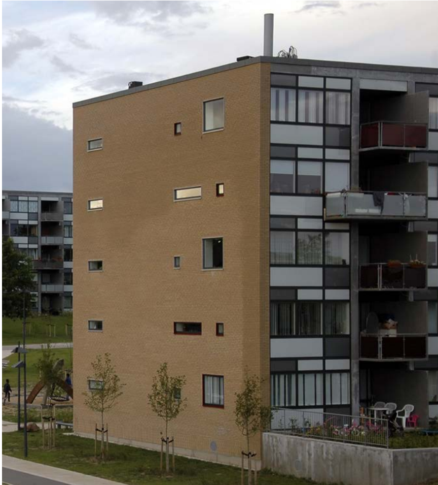
Figur 60. Nye gavlvinduer. Gavlene er blevet skalmuret og er blevet åbnet med nye vinduer.
