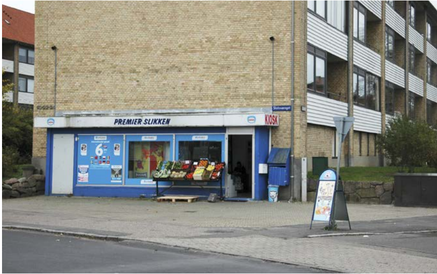
Figur 107. Butikslokaler. Den lille butik nedlægges i forbindelse med den igangværende renovering.
