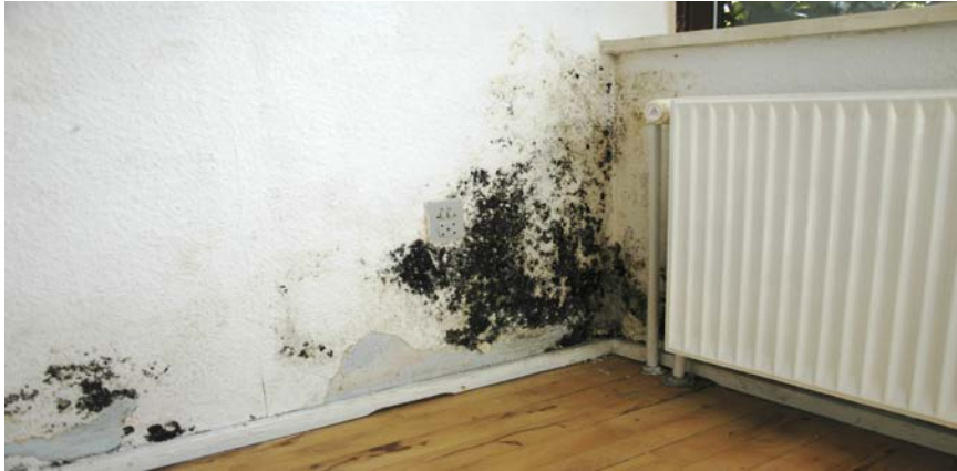
Figur 76. Skimmelsvamp . Renoveringen af bebyggelsen var primært begrundet i omfattende problemer med skimmelsvamp.
