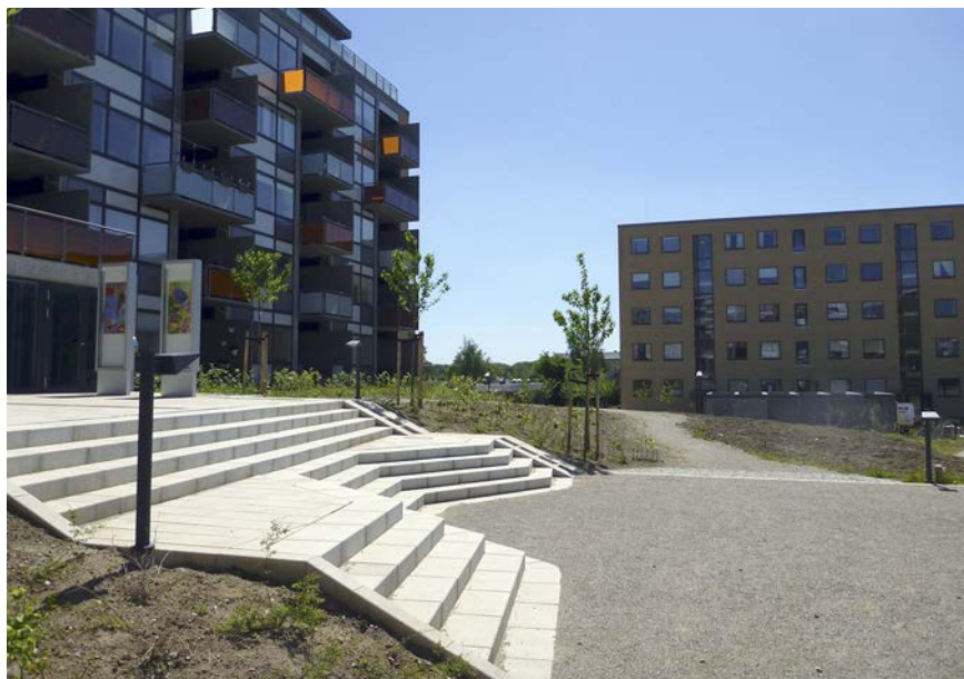
Figur 66. Rampe i terræn supplerer trapper. Der mangler kontraster på trappeforkanterne og håndlister at holde fast i, men der er tænkt på fx rollatorbrugere på havesiden af de nye aktivitetsrum.
