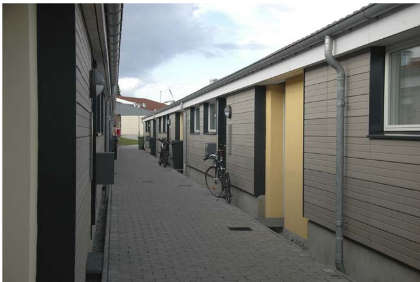
Figur 79. Terrænet er hævet i passagen mellem bygningerne. Der er etableret en rende langs facaderne. Renden er overdækket med riste ved dørene.
