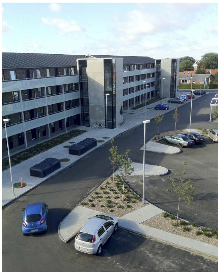
Figur 137. Etablering af ældreegnede boliger. De to blokke, der udvalgte til opgradering som ældreegnede, ligger med indkøbsmulighed lige overfor, i højre kant af billedet. Hullerne i gangbanerne til venstre kan måske være en udfordring for svagtseende. Der plantes dog træer i hullerne, der dermed bliver mere synlige med tiden.
