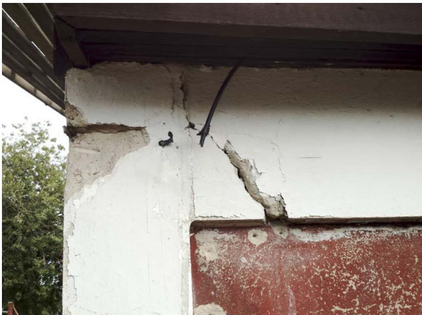
Figur 111. Thrigesvej før renovering. Bebyggelsen var plaget af byggetekniske problemer. (Foto: C.F. Møller).
