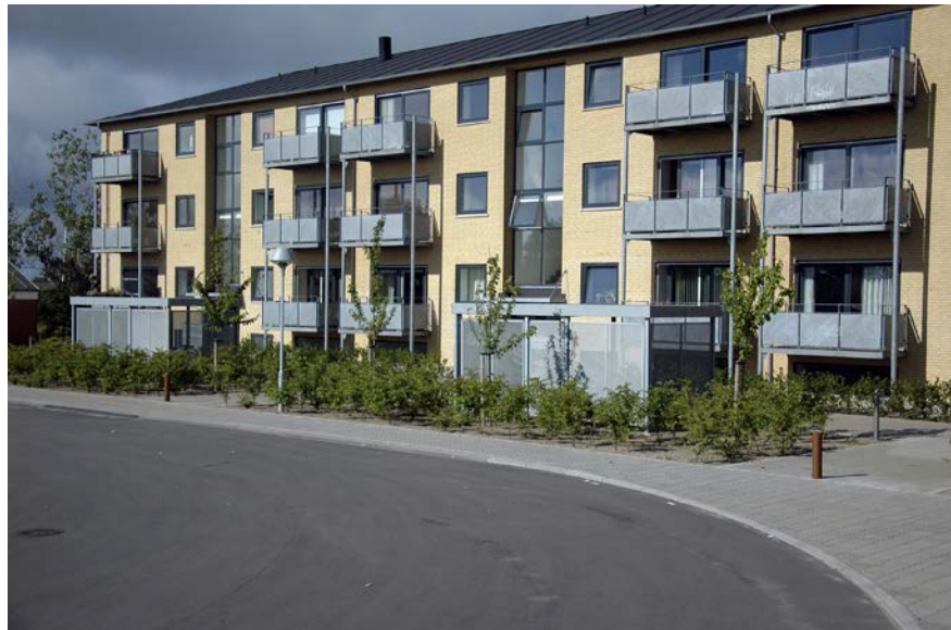
Figur 120. Genanvendte altaner. Renoveret boligblok med genanvendte altaner.
