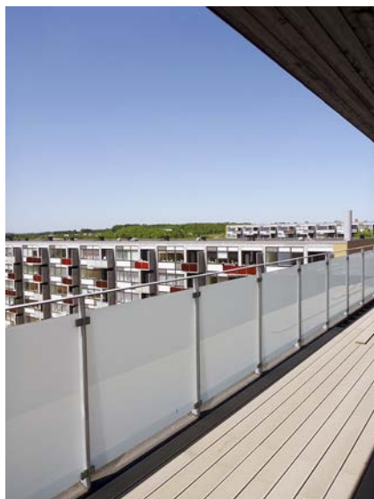
Figur 63. Trinfri adgang. Tagaltanerne og boligerne er på alle måde meget attraktive, men i detailafdelingen kniber det med at finde skydedøre på markedet, som har lave bundstykker til trinfri adgang.
