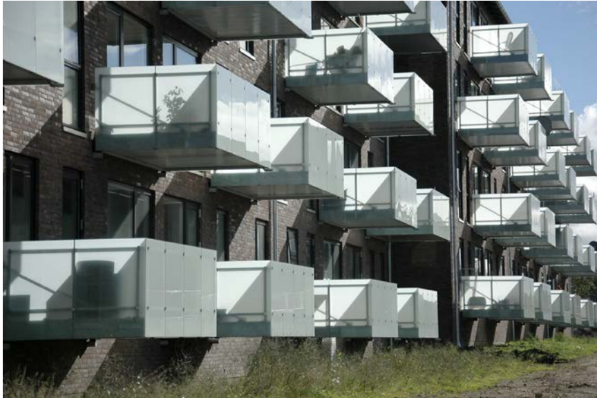
Figur 133. Nye altaner efter renovering. Bebyggelsens vestvendte facader med nye altaner.
