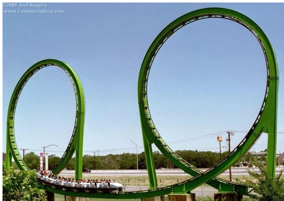
Figur 13. Overgangskurver optræder ikke i vejenes længdeprofil. Derimod udnyttes klotoidens kørselsdynamiske kvaliteter også i det vertikale plan på visse rutschebaner. Figuren viser klotoid-loops på rutschebanen Shockwave i forlystelsesparken "Six Flags over Texas", Arlington, Texas. Fra http://www.coastergallery.com/2001T/SFOT.html .
