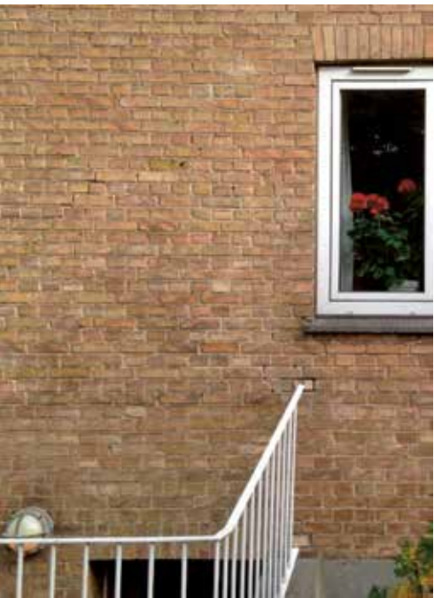
ØVERST Fortunbyen, Kgs. Lyngby. Mindre sætningsrevner uden konstruktiv betydning. Reparation, hvor jerngelænder går i murværket.
