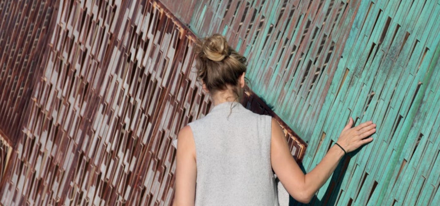
Sense 3 (2014): Responsiv bygningsfacade baseret på nyudviklede kompositkonstruktioner der regulerer det indre termiske miljø drevet af det ydre termiske miljø. Projekt: Isak Worre Foged og Anke Pasold (AREA), støttet af Realдания (Foto: Isak Worre Foged).
