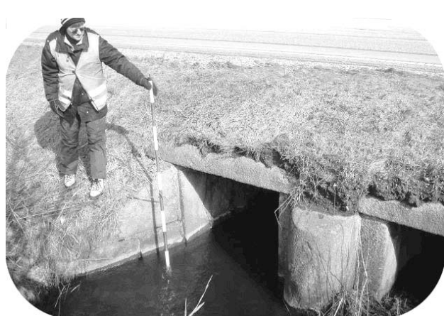
Figur 51. Vandunderløb i strækningens vestlige side ved km 7,98.
