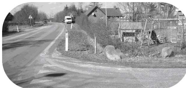
Figur 56. Delstrækningen fra km 3,00 til km 3,23.
