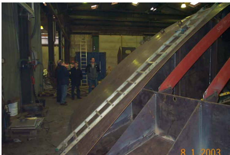
Midterdel af rampe under opsvejsning.
