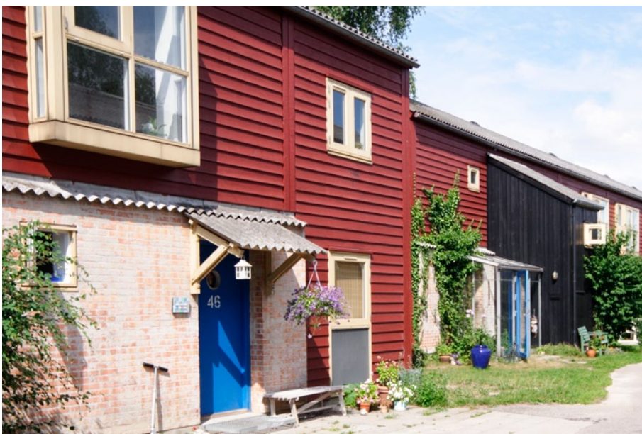
1970'erne: Den demokratiske bolig med fast kerne og fleksible beboelsesrum Tinggården, Herfølge Arkitekt: Tegnestuen Vandkunsten Ingeniør: Viggo Michaelsen a/s Opførelse: 1978
