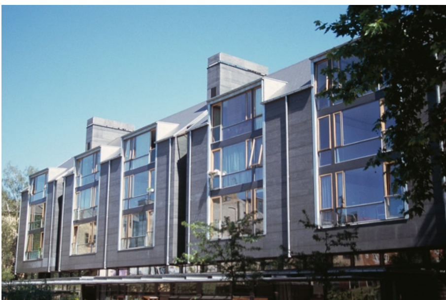
1990'erne: Den intelligente bolig med decentralisering af bygningens servicezoner Prinsessegade, Christianshavn Arkitekt: Tegnestuen Vandkunsten Ingeniør: Lemming & Eriksson Opførelse: 1999-2000
