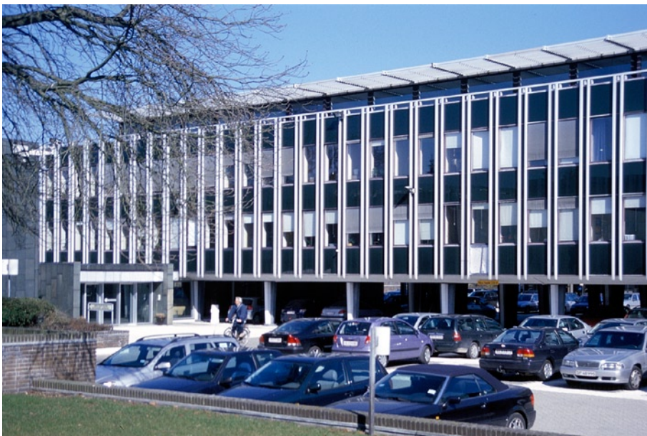
1970'erne: Det demokratiske kontor med funktionsopdeling langs bygningens midterakse WHO's regionalkontor for Europa, København Arkitekt: Svend Eske Kristensen Ingeniør: Schøning, Kjeldsen & Støttrup Opførelse: 1972
