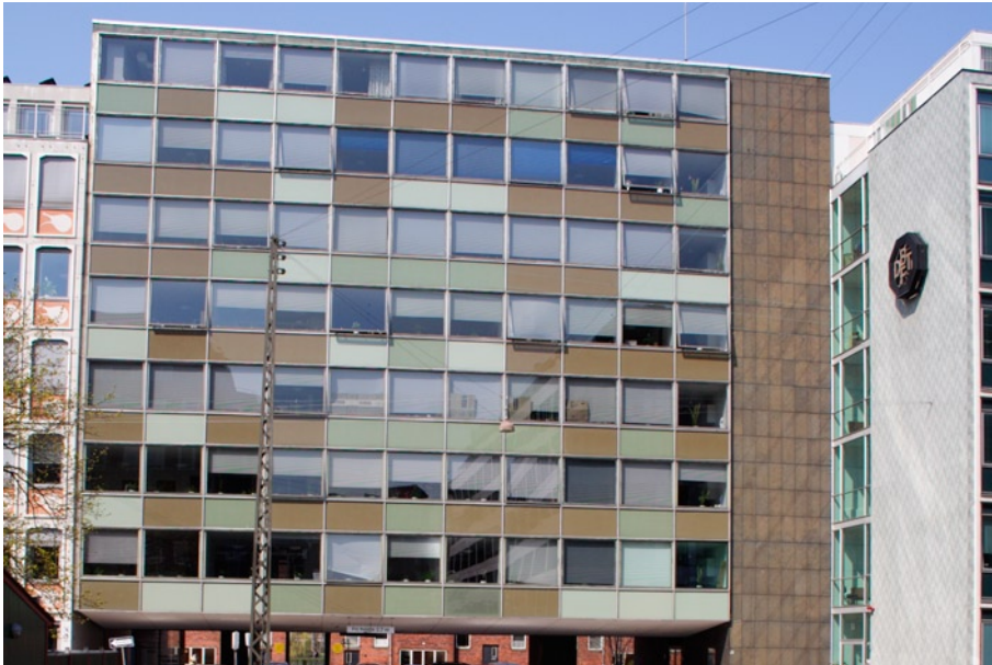
1950'erne: Det moderne kontor med funktionsopdeling på tværs af bygningen Hovedkontor for A. Jespersen & Søn, København Arkitekt: Arne Jacobsen Ingeniør: M Folmer Andersen Opførelse: 1955
