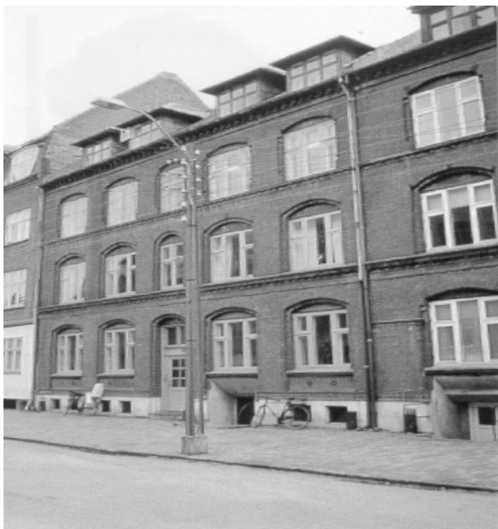
Figur 13. Gedefacade af Jagtvej 30, Odense efter renovering.
