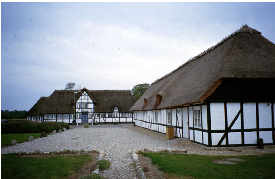
Figur 39. Vester Skerninge Kro, med den ombyggede krosal i længen til højre i billedet til et lokalt brugerhus med en kultursal til kulturelle arrangementer og udstillinger.
