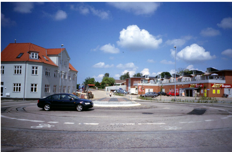
Figur 25. Rundkørslen med renoveret byhus tv. og den nye Dagli'Brugsen th.
