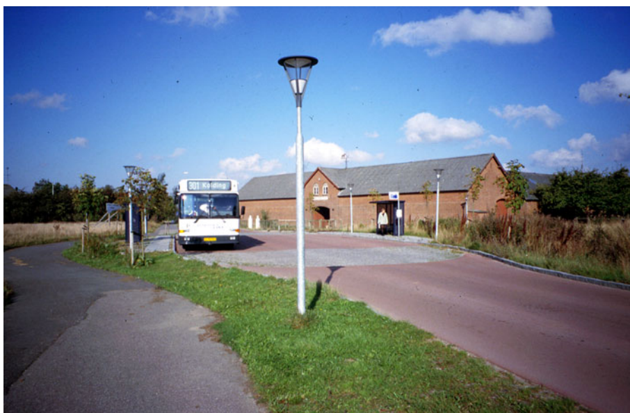
Figur 33. Den ovale plads er etableret med særlig vejbelægning, lysarmaturer, busholdeplads med læskur, og skærmende træer er plantet omkring pladsen. Pladsen er tilgængelig til fods dels fra den gamle bydel, dels fra et nybyggerområde.
