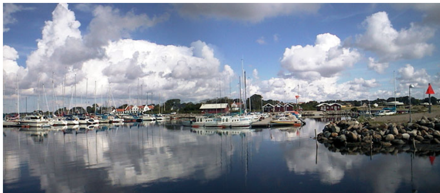
Figur 14. Gjøel Havn er udbygget til lystbådehavn med klubhuse m.m. for sejl- og roklubben.
