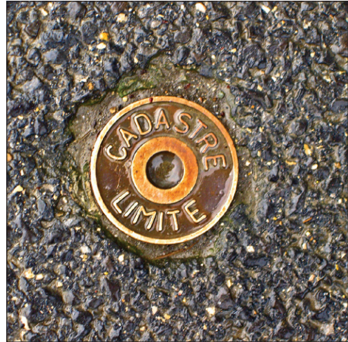
Figura 12.11 En Suiza se usa una marca de un límite en la tierra con un pasador metálico.
