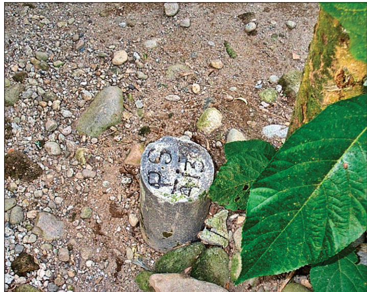
Figura 12.12 Una marca de un límite de concreto que identifica numéricamente la marca se usa en Filipinas.
