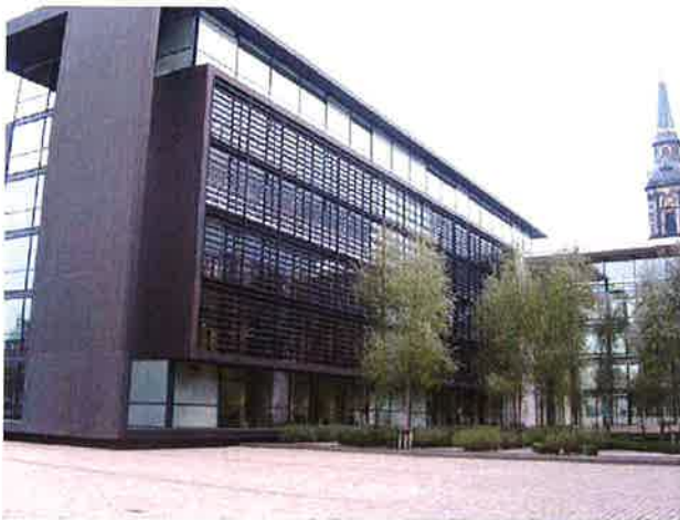
Figur 4.7: Nordea bygningens sydfacade med eksisterende solafskærmning, øverst til venstre: den udvendige solafskærmning bestående af glaslameller med silketrykt mønster øverst til højre; den udvendige solafskærmning hvor glaslamellerne er helt lukkede nederst til venstre: En sydfacade i Nordeas domicil.
