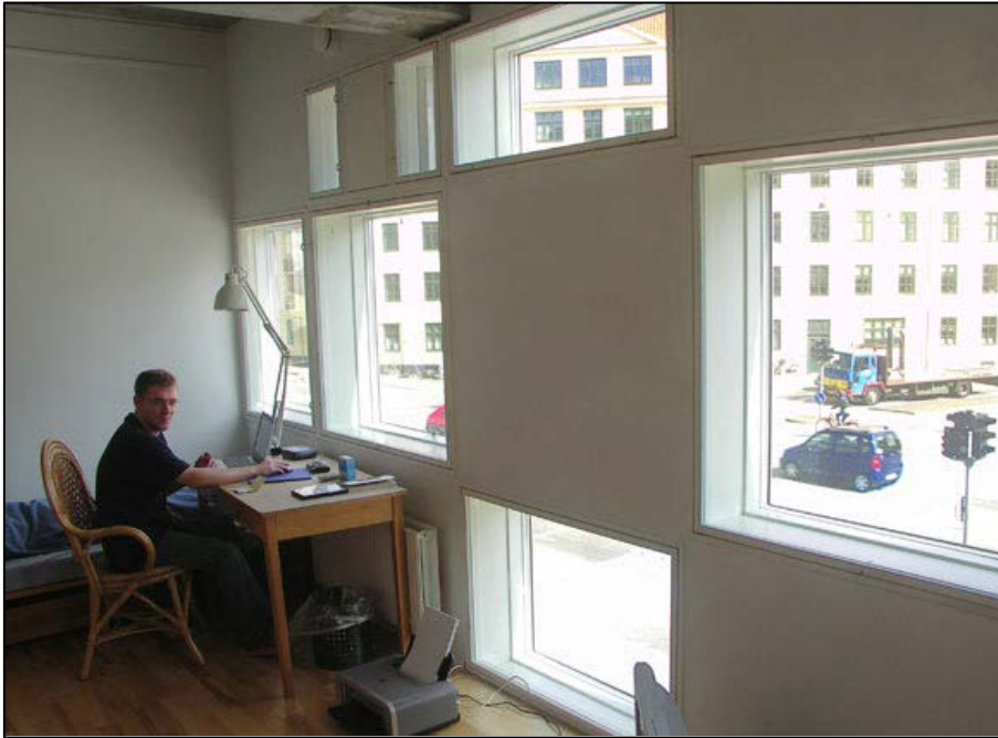
Figur D.3. Vinduesvæg i kollegieværelse. Ventilationsvinduet med lydslusen ses som de to små vinduer foroven over skrivebordet. Foto gengivet fra [D2].
