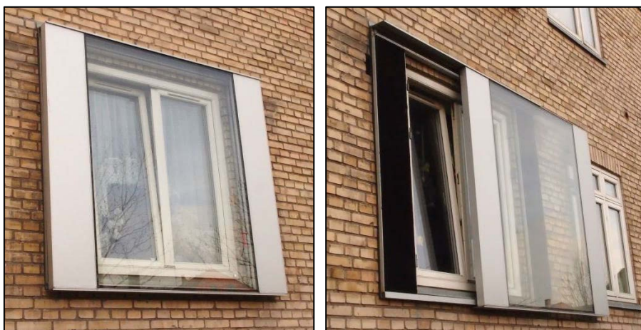
Figur A.3. Fotos af lydskoddens udseende og funktion. På foto til venstre ses den lukkede lydskodde, til højre lydskodden kørt til siden. På begge fotos er det eksisterende side-bundhængte, indadgående vindue åbnet i ventilationsstilling.
