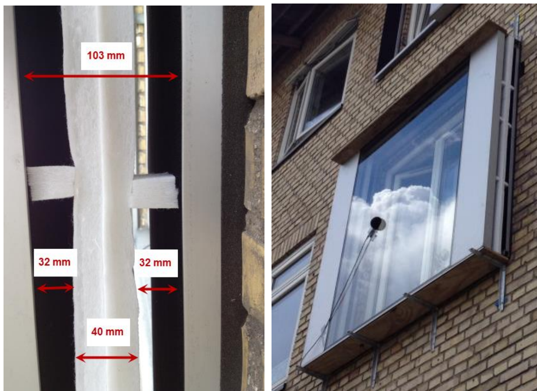
Figur 4 Den udrykkede lydskodde med isat 40 mm lydabsorberende materiale. Til venstre et nærbillede af den udvidede spalte med de 40 mm lydabsorberende materiale placeret midt i spalten.
