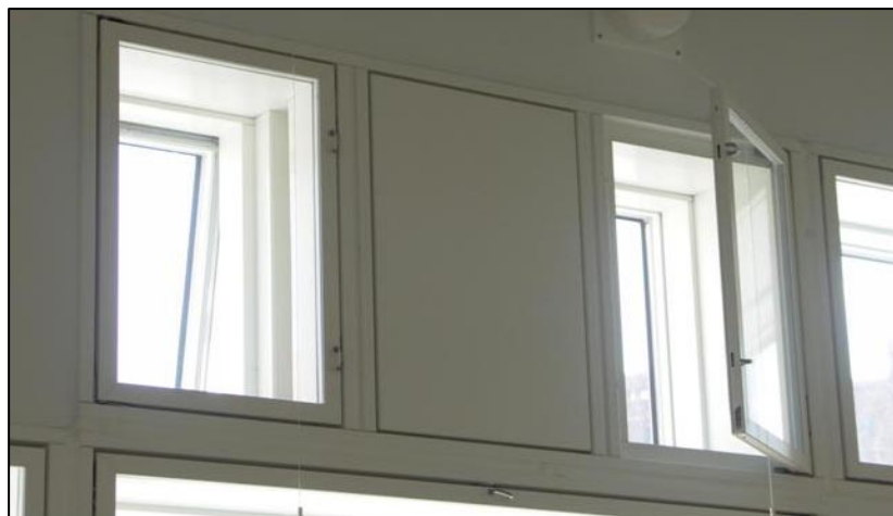
Figur D.2. Foto af ventilationsvindue med lydsluse anvendt i Bikuben Kollegiet, Ørestad, København. Placering af vindue i facadevæg ses på figur D.3. Foto gengivet fra [D2].
