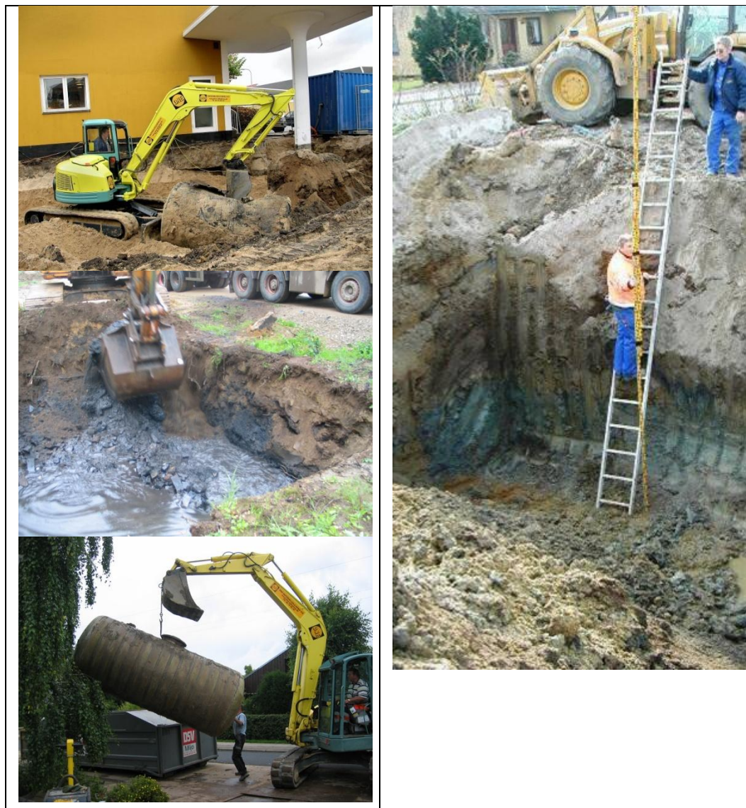
Figur 1: Billeder fra håndtering af tanke og udgravning på forurenede ejendom.
