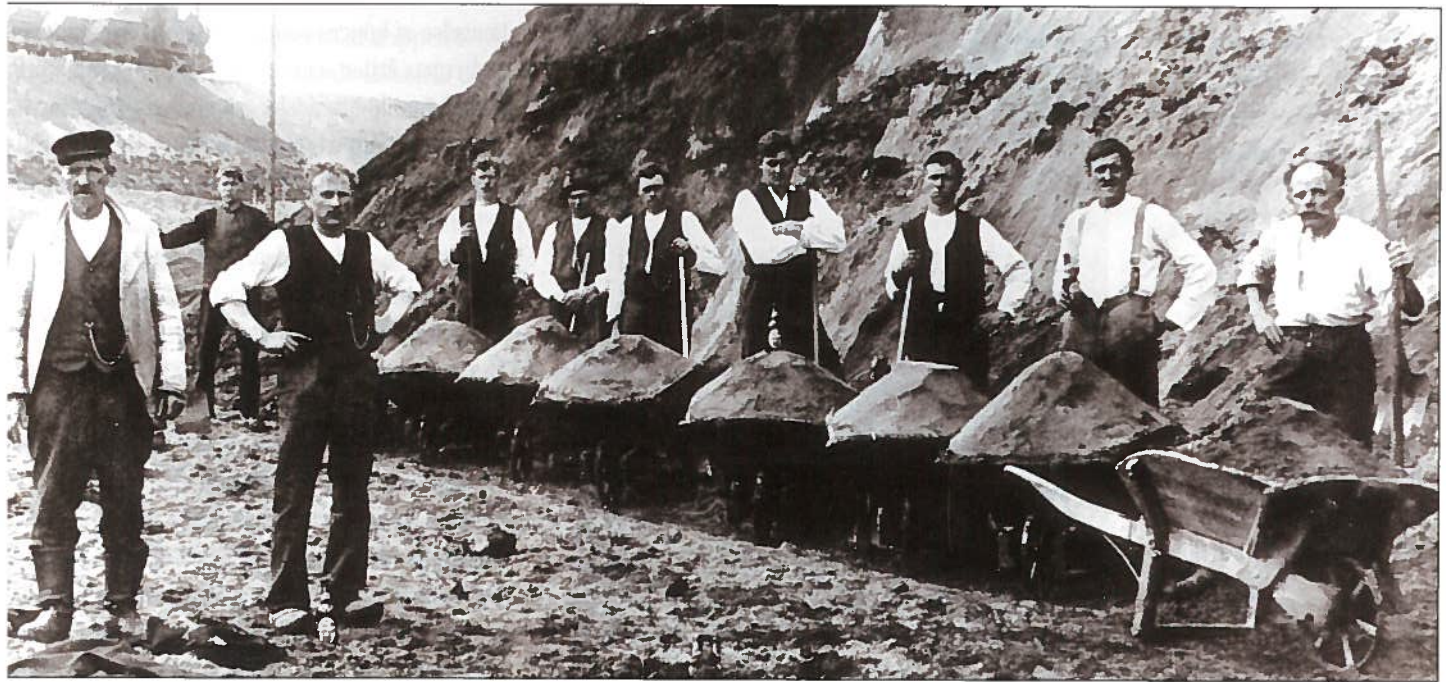
Et såkaldt »trillesjak« under arbejdet med udgravning af indløbskanalen til elværket, 1919. Billedet udlånt af Elmuseets arkiv.
