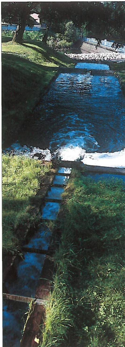
Fisketrappen ved Tangeværket. Bassinet neden for værkets tur- biner skimtes øverst i billedet. Foto: Finn Arler.
