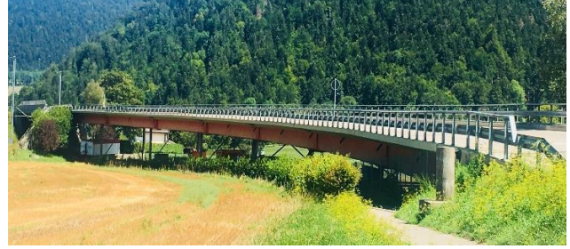
Figure 1: View of the Crêt de l'Anneau Viaduct
