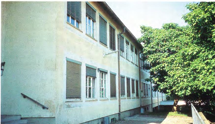
▲ Südfassade des Klassenzimmertrakts des 1. Bauabschnitts. Die Sonnenschutz-einrichtungen sind meist ganztags geschlossen und die Räume werden künstlich beleuchtet. Eine tageslichtabhängige Beleuchtungssteuerung soll den Sonnenschutz so steuern, daß, soweit vorhanden, genügend Tageslicht in die Räume gelangt und kein Kunstlicht benötigt wird.
