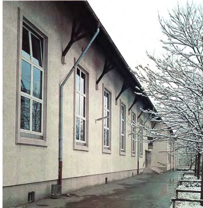
Seitenansicht der Turnhalle mit Eingangsbereich (Bauteil 1 und 2). Die Fenstergewände und Balkenaufleger sollen gestalterisch erhalten bleiben.
